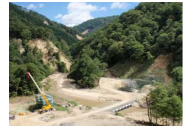
工事状況全景(平成21年9月9日)
