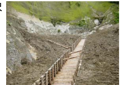
木製水路工施工状況 (平成21年9月2日)
