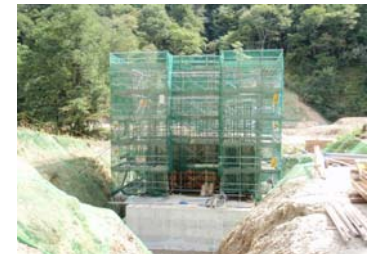
トラス橋右岸橋台鉄筋組立状況 (平成21年9月9日)
