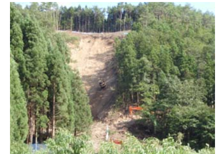
法切工施工状況(平成21年9月7日)
