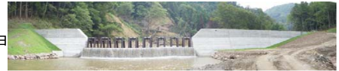
スリットダム完成(平成21年6月22日)
