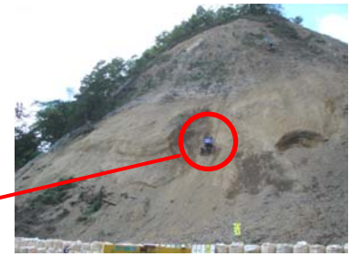
RCMIによる法面掘削状況(平成21年8月24日)
