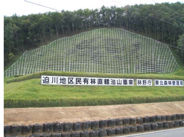
吹付砕工 工事完成 (平成21年8月4日)
