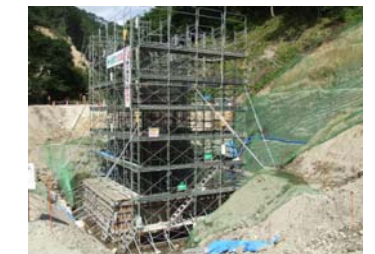
トラス橋左岸橋台鉄筋組立状況 (平成21年9月9日)
