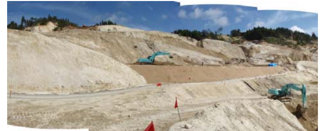
排土工施工状況(平成21年9月7日)
