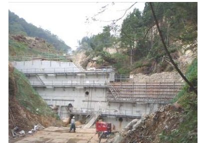
谷止工施工状況(平成21年8月20日)
