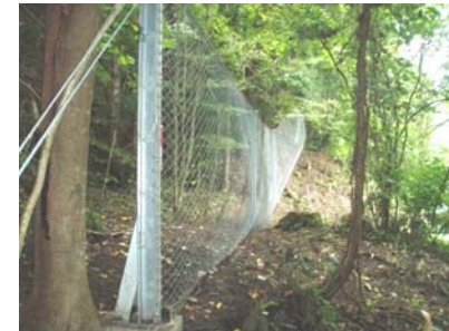
落石防護柵の設置(平成21年8月28日)
