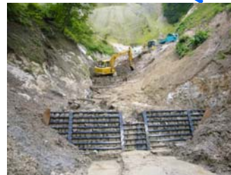
鋼製土留工施工状況 (平成21年9月2日)
