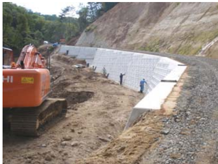
(3～11号)7号工事状況 (平成21年9月7日)
