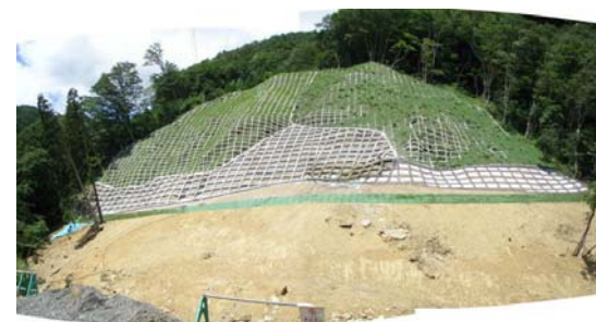
法砕工施工状況(平成21年8月24日)
