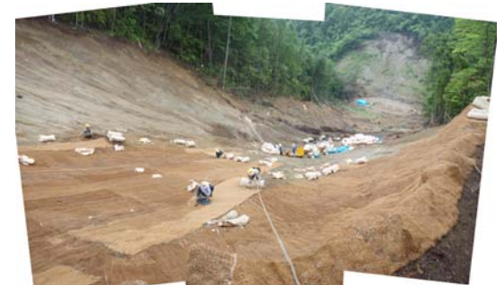
緑化工 工事状況(平成21年7月24日)
