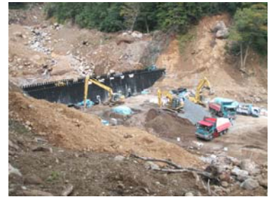
INSEM鋼製谷止工の施工状況(平成21年9月1日)
