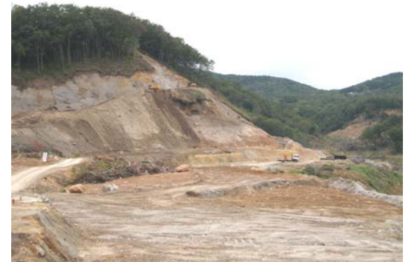
工事状況(平成21年9月8日)
