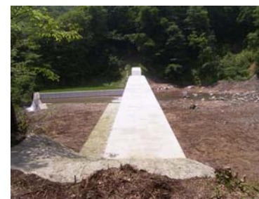
コンクリート谷止工 (平成21年7月15日)
