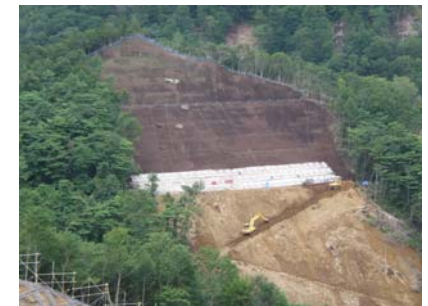
山腹工 工事状況(平21年7月14日)
