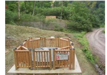
集水井完成状況(平成21年8月31日)
