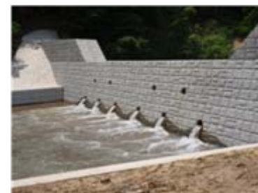
コンクリート谷止工 工事状況 (平成21年6月5日)
