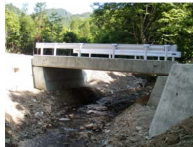
橋梁付替(平成21年6月25日)
