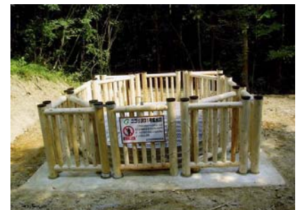
集水井完成状況(平成21年7月27日)
