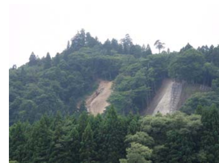
山腹工 工事状況 (平成21年7月15日)
