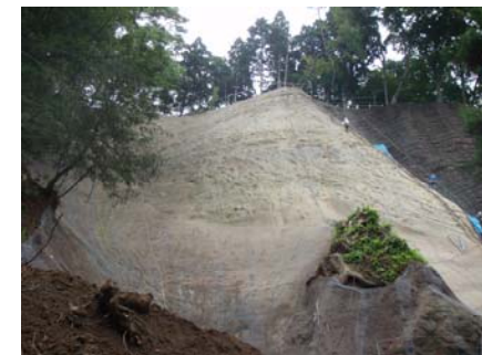
山腹工 工事状況 (平成21年7月14日)
