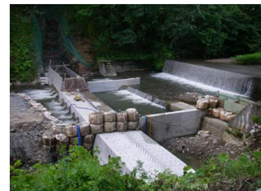
工事状況(平成21年7月15日)
