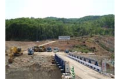
工事状況(平成21年5月26日)
