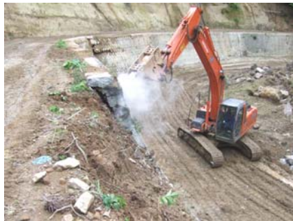
9号 被災ブロック取り壊し状況 (平成21年9月2日)
