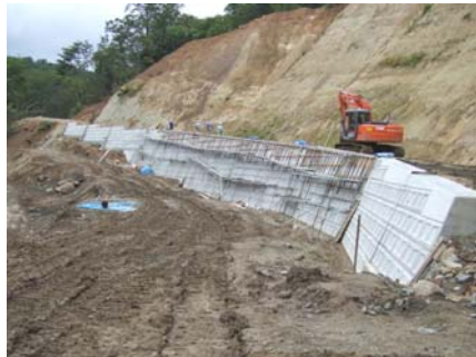
(3～11号)7号工事状況 (平成21年9月2日)
