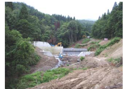
谷止工施工状況(平成21年8月7日)
