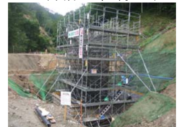
トラス橋左岸橋台鉄筋組立状況 (平成21年9月2日)
