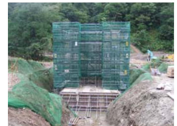
トラス橋右岸橋台鉄筋組立状況 (平成21年9月2日)
