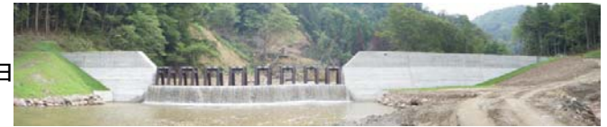
スリットダム 工事完成 (平成21年6月22日)
