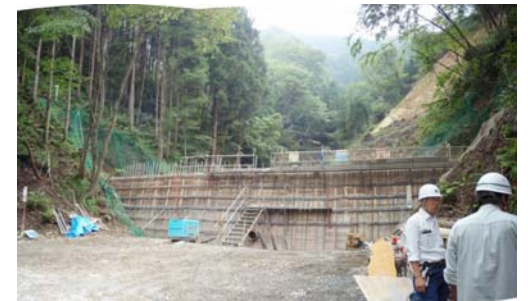
谷止工施工状況 (平成21年8月20日)
