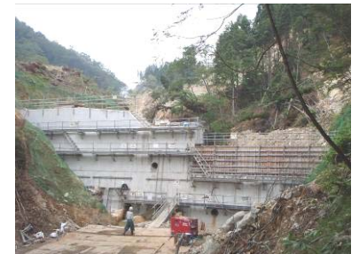
谷止工施工状況(平成21年8月20日)
