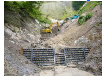
鋼製土留工施工状況 (平成21年9月2日)
