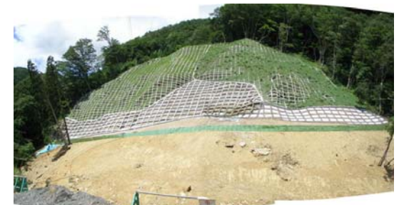
法砕工施工状況(平成21年8月24日)
