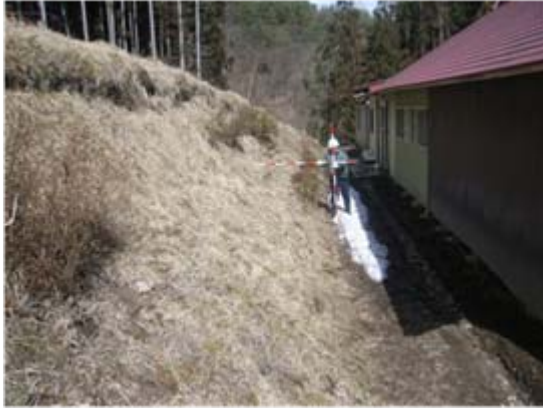
民家裏斜面の防災点検
