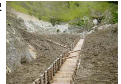
木製水路工施工状況 (平成21年9月2日)
