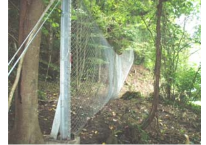
落石防護柵の設置(平成21年8月28日)
