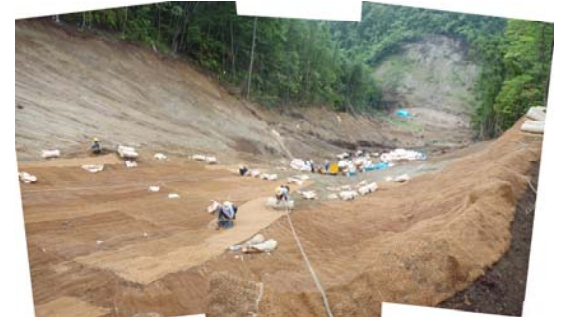
緑化工 工事状況 (平成21年7月24日)
