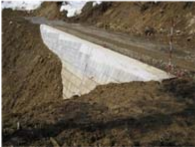
二段式擁壁完了
