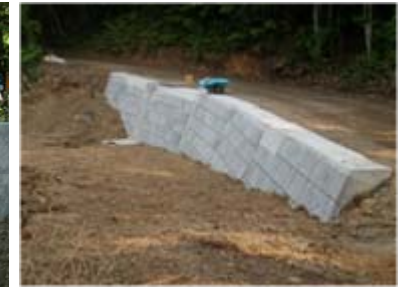
コンクリートブロック積工ほかの 工事に着手しました。(平成 21年5月19日)
