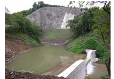
山腹工 工事完成 (平成21年8月31日)
