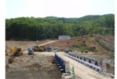
工事状況(平成21年5月26日)
