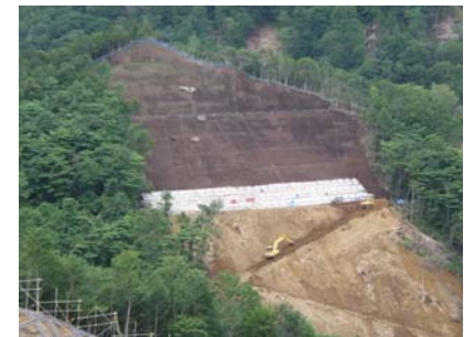
山腹工 工事状況 (平21年7月14日)
