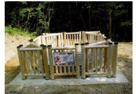
集水井完成状況(平成21年7月27日)
