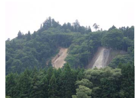
山腹工 工事状況 (平成21年7月15日)
