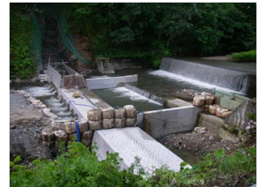
工事状況(平成21年7月15日)
