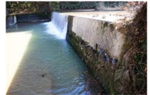
産女川治山ダム 施設被害状況
