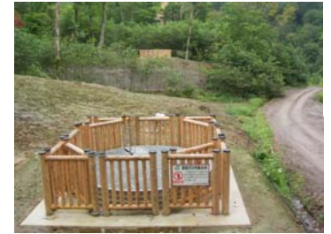
集水井完成状況(平成21年8月31日)
