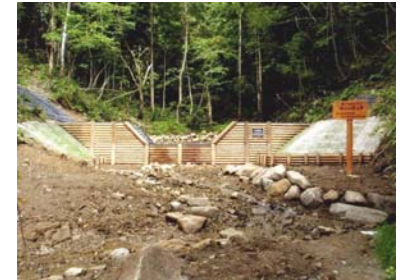
工事完成 (平成21年8月11日)
