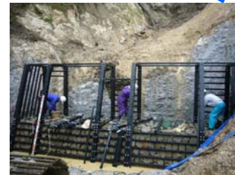
鋼製土留工施工状況 (平成21年8月21日)
