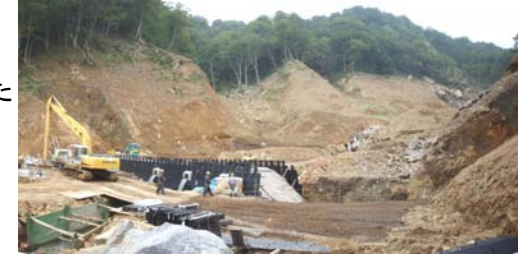
INSEM鋼製谷止工の施工状況(平成21年8月17日)
