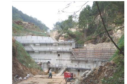
谷止工施工状況(平成21年8月20日)
