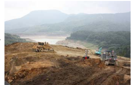
排土工施工状況 (平成21年8月19日)
