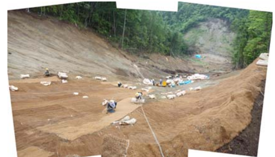
緑化工 工事状況 (平成21年7月24日)
