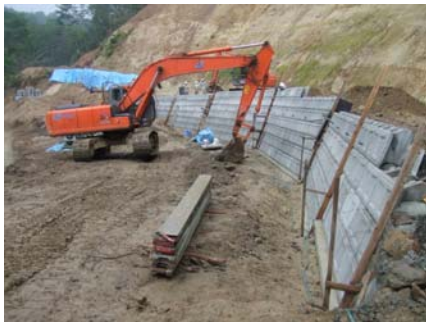
(3～11号)7号工事状況 (平成21年8月21日)
