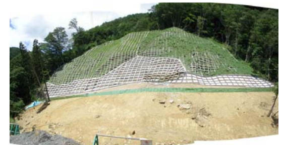
法砕工施工状況(平成21年8月24日)
