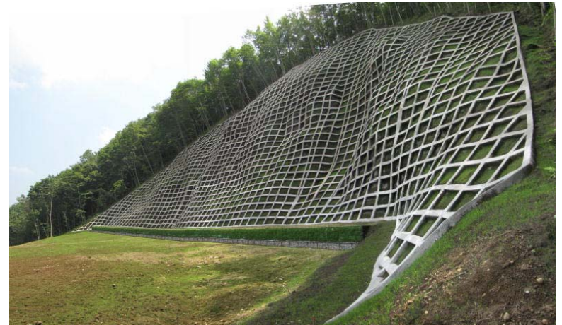
吹付枠工 工事完成 (平成21年8月4日)
