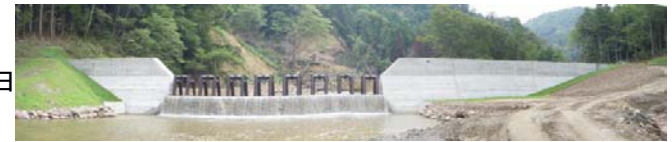
スリットダム 工事完成 (平成21年6月22日)
