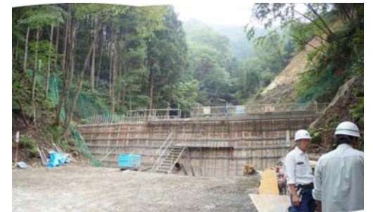
谷止工施工状況 (平成21年8月20日)
