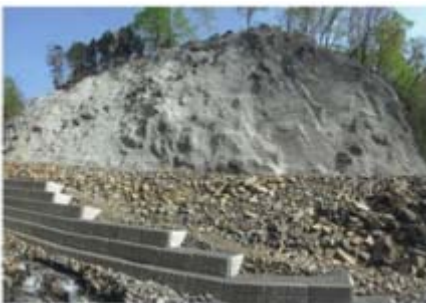
モルタル吹付等完了
