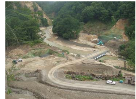
河原小屋林道災害復旧工事 トラス橋床掘状況・遠景 (平成21年8月20日)
