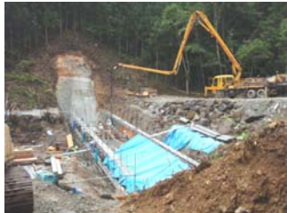
谷止工施工状況 (平成21年8月21日)
