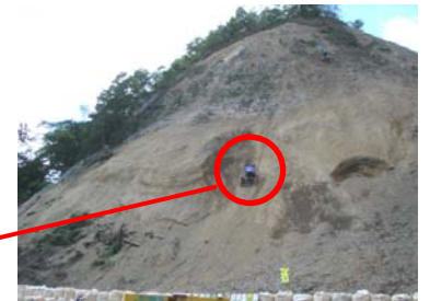
RCMIによる法面掘削状況(平成21年8月24日)
