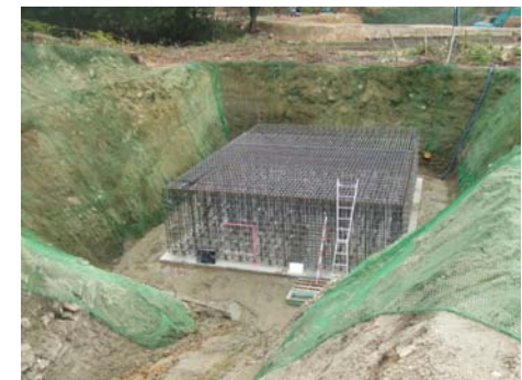
河原小屋林道災害復旧工事 トラス橋右岸橋台鉄筋組立状況 (平成21年8月20日)
