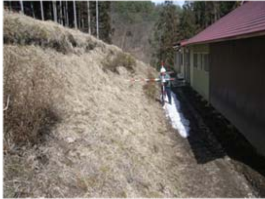
民家裏斜面の防災点検
