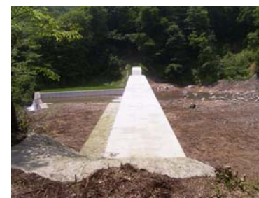
コンクリート谷止工 (平成21年7月15日)
