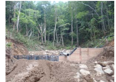
工事状況(平成21年7月15日)
