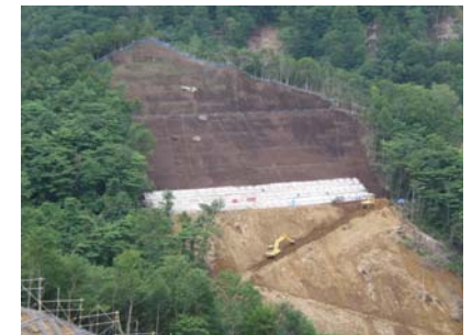
山腹工 工事状況(平成21年7月14日)
