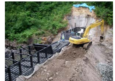
鋼製谷止工 工事状況(平成21年7月15日)
