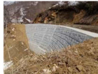
コンクリートブロック擁壁完了
