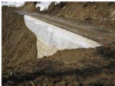
二段式擁壁完了
