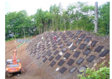
山腹工 工事状況(平成21年7月15日)
