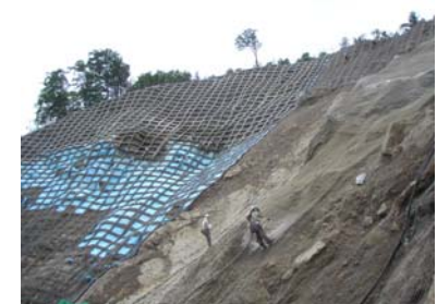
山腹工 工事状況(平成21年7月14日)
