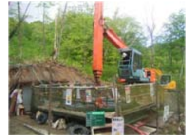
集水井工掘削状況(平成21年6月11日)
