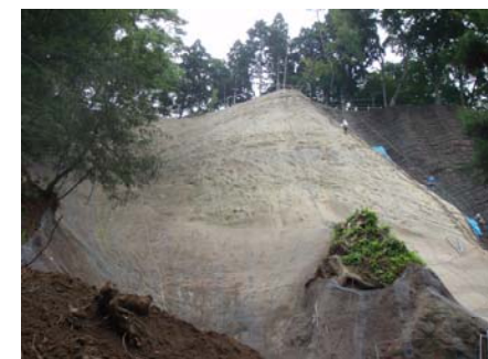
山腹工 工事状況 (平成21年7月14日)
