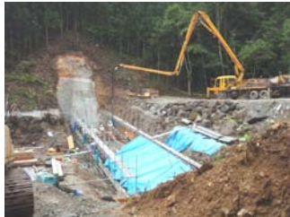
谷止工打設の様子 (平成21年8月21日)
