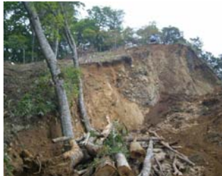
RCMIによる頭部排土状況(平成21年8月4日)
