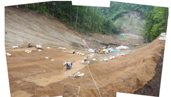
緑化工 工事状況 (平成21年7月24日)
