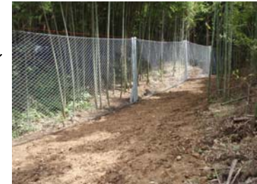
工事状況(平成21年7月16日)
