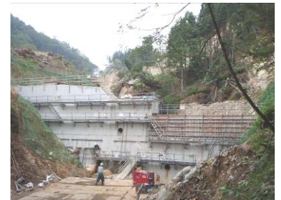
谷止工施工状況(平成21年8月20日)
