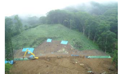
法砕工の施工状況(平成21年7月24日)
