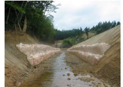
仮排水路施工状況 (平成21年8月5日)
