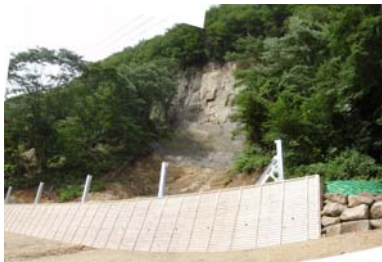
工事状況(平成21年7月16日)
