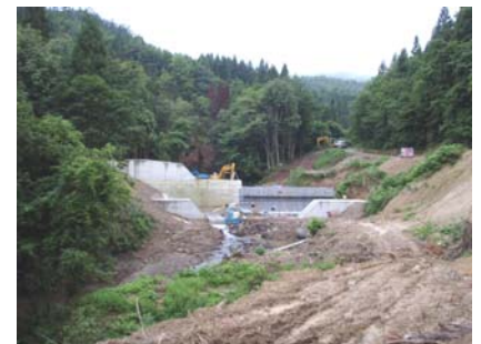
谷止工施工状況(平成21年8月7日)
