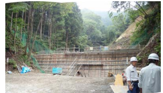
谷止工施工状況 (平成21年8月20日)
