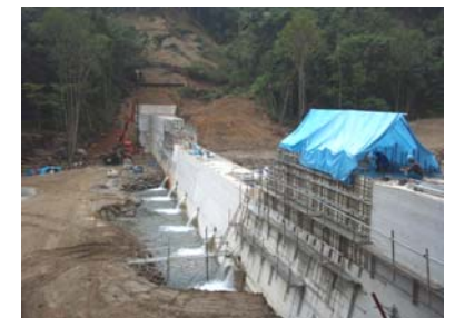
谷止工施工状況(平成21年8月19日)
