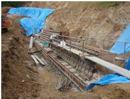
(3～11号)7号工事状況 (平成21年7月27日)
