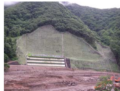
工事状況(平成21年7月23日)
