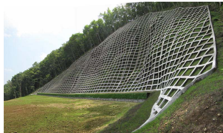
吹付枠工 工事完成 (平成21年8月4日)
