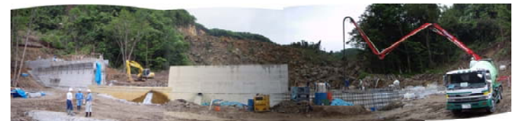
谷止工施工状況(平成21年7月9日)
