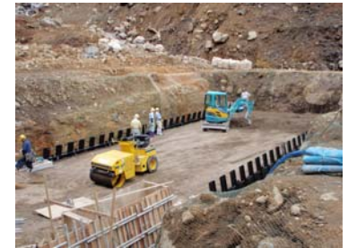
谷止工の施工状況(平成21年7月16日)
