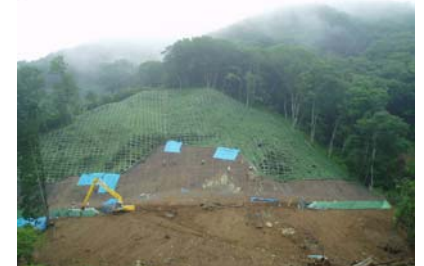
法砕工の施工状況(平成21年7月24日)
