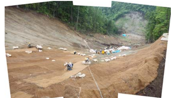
緑化工 工事状況(平成21年7月24日)
