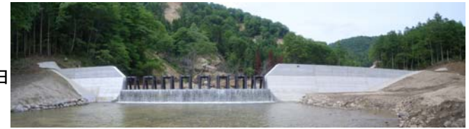
スリットダム 工事完了(平成21年6月17日)
