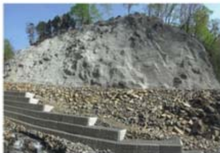
モルタル吹付等完了
