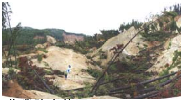
作業路内状況 (平成21年7月2日)
