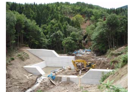
谷止工施工状況(平成21年7月15日)
