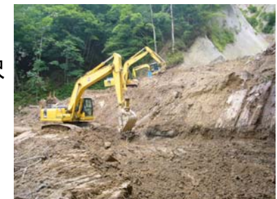
工事状況(平成21年7月14日)
