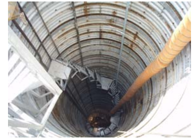
集水井工の施工状況 (平成21年6月25日)
