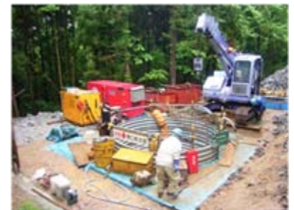
集水井工掘削状況(平成21年6月5日)
