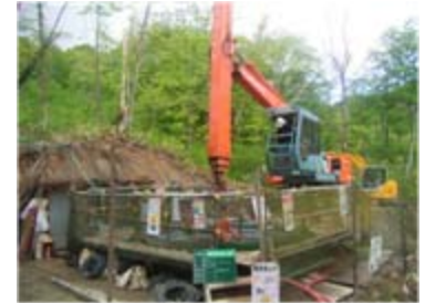
集水井工掘削状況(平成21年6月11日)
