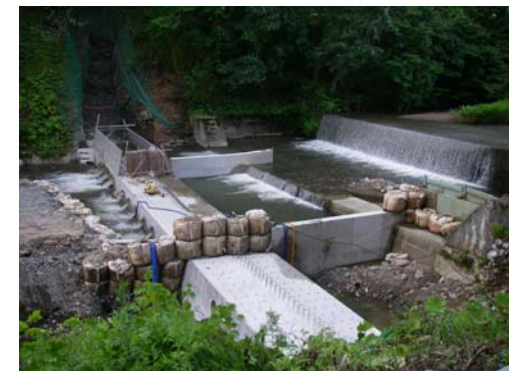
工事状況(平成21年7月15日)
