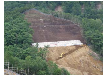
山腹工 工事状況(平成21年7月14日)
