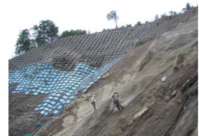
山腹工 工事状況(平成21年7月14日)
