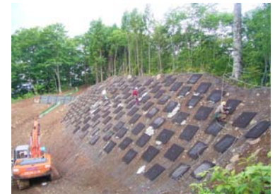
山腹工 工事状況(平成21年7月15日)
