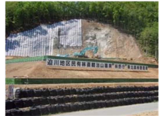
吹付砕工 工事状況 (平成21年5月19日)
