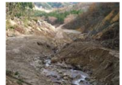
河道掘削工事完了(平成20年10月20日)
