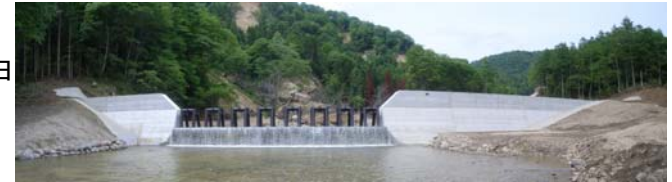
スリットダム 工事完了(平成21年6月17日)
