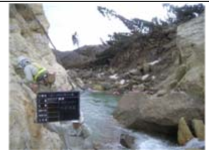
土石流センサーの設置(平成21年4月2日)
