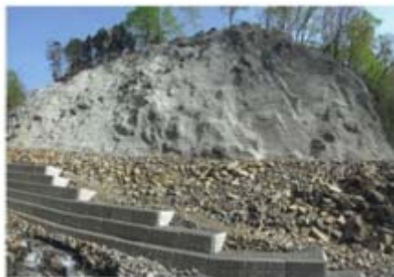
モルタル吹付等完了
