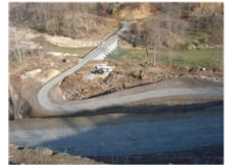
資材運搬路 工事完了(平成20年11月15日)
