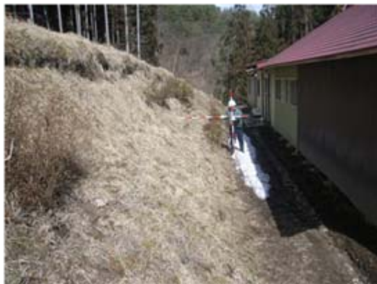
民家裏斜面の防災点検
