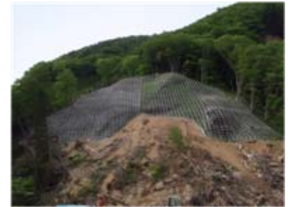
法砕工の施工状況(平成21年5月25日)
