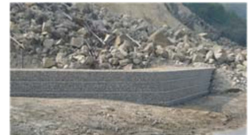
大型カゴ枠工 完了(平成20年9月27日)
