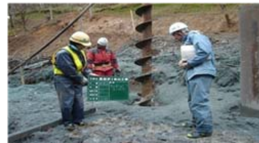
工事状況(セメントミルク注入)
