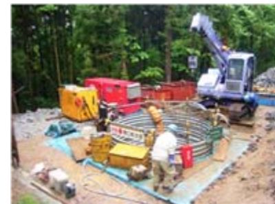
集水井工掘削状況(平成21年6月5日)
