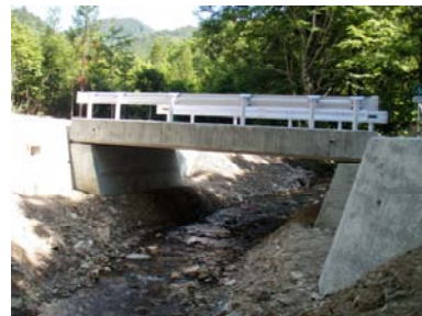
橋梁付替(平成21年6月25日)
