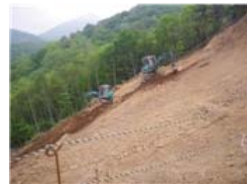
山腹工 工事状況(平成21年5月14日)
