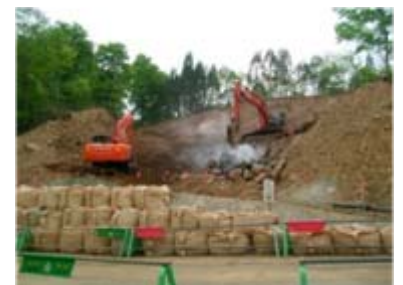
山腹工工事状況(平成21年5月11日)
