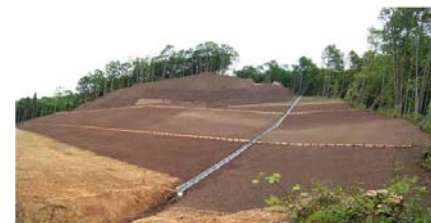
排土工工事状況(平成21年6月18日)
