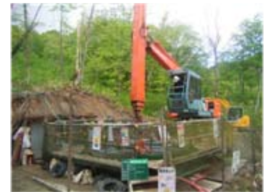
集水井工掘削状況(平成21年6月11日)
