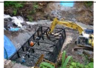
鋼製谷止工詰石状況(平成21年6月11日)
