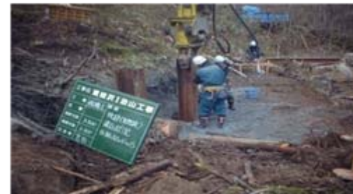
工事状況(H鋼建込)
