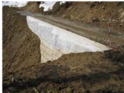
二段式擁壁完了
