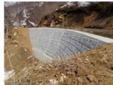
コンクリートブロック擁壁完了
