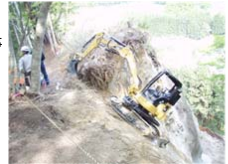
山腹工 工事状況(平成21年5月11日)
