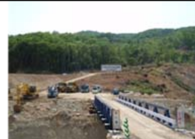
工事状況(平成21年5月26日)
