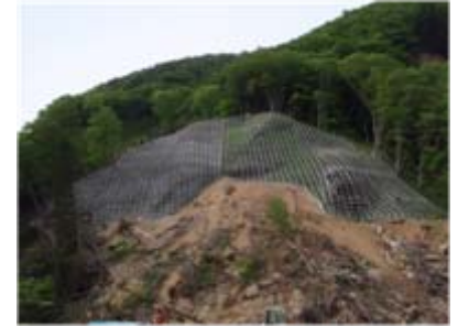
法砕工の施工状況(平成21年5月25日)
