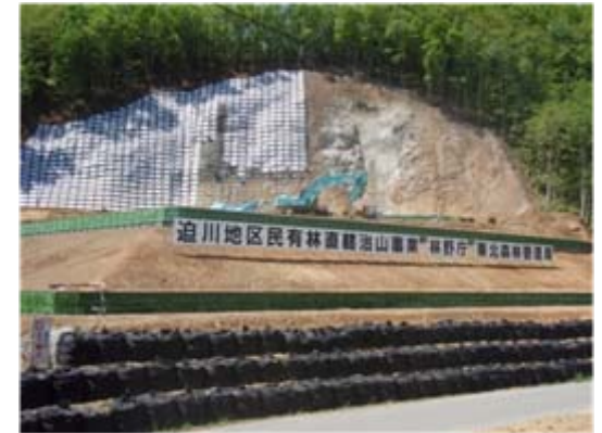
吹付枠工 工事状況 (平成21年5月19日)
