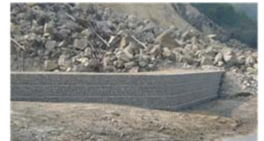
大型カゴ枠工 完了(平成20年9月27日)
