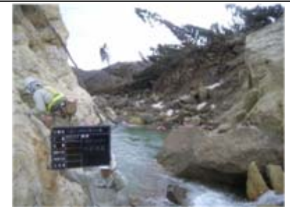
土石流センサーの設置(平成21年4月2日)
