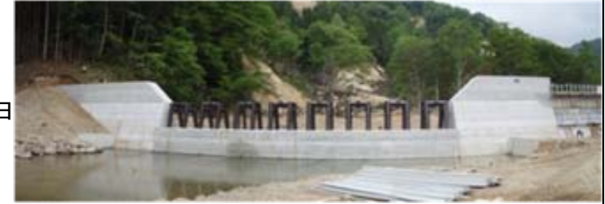
スリットダム 工事状況(平成21年5月28日)
