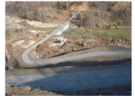
資材運搬路 工事完了(平成20年11月15日)
