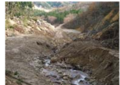
河道掘削工事完了(平成20年10月20日)
