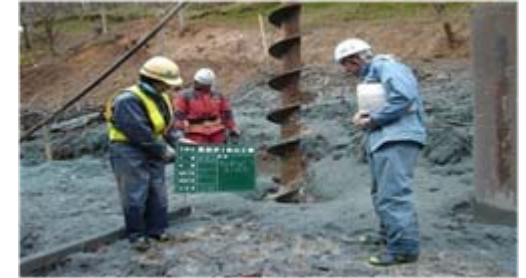
工事状況(セメントミルク注入)
