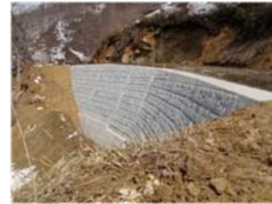
コンクリートブロック擁壁完了
