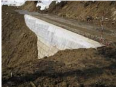
二段式擁壁完了
