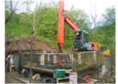
集水井工掘削状況(平成21年6月11日)
