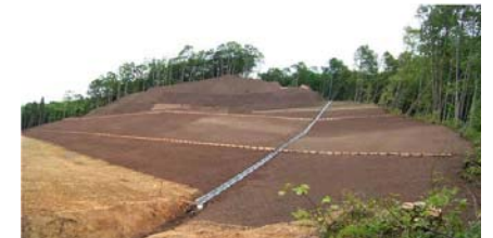
排土工工事状況(平成21年6月18日)
