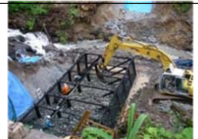
鋼製谷止工詰石状況(平成21年6月11日)
