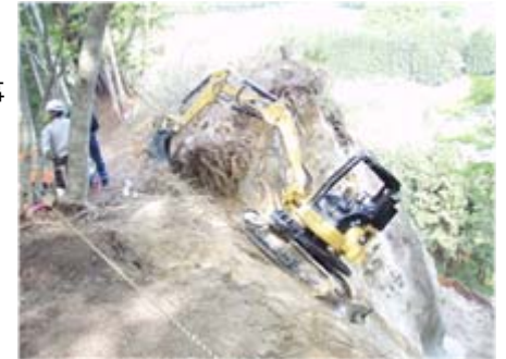
山腹工 工事状況 (平成21年5月11日)
