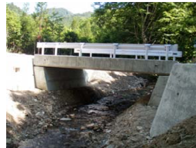
橋梁付替(平成21年6月25日)
