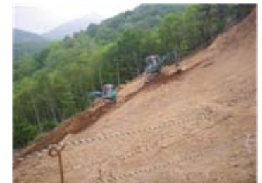
山腹工 工事状況(平成21年5月14日)
