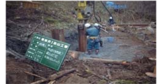
工事状況(H鋼建込)
