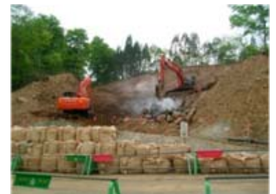
山腹工工事状況(平成21年5月11日)
