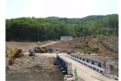
工事状況(平成21年5月26日)
