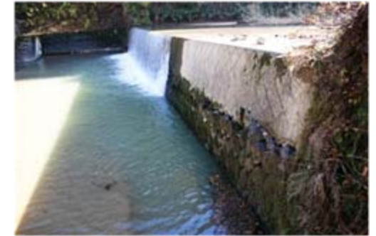
産女川治山ダム 施設被害状況
