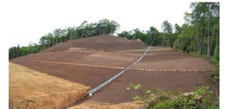
排土工工事状況(平成21年6月18日)
