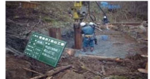
工事状況(H鋼建込)
