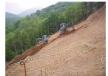
山腹工 工事状況(平成21年5月14日)
