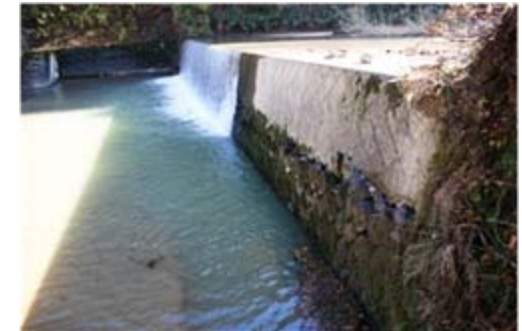
産女川治山ダム 施設被害状況
