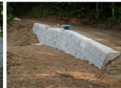
コンクリートブロック積工ほかの工事に着手しました。(平成21年5月19日)
