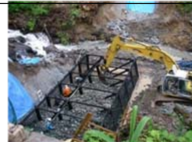
鋼製谷止工詰石状況(平成21年6月11日)
