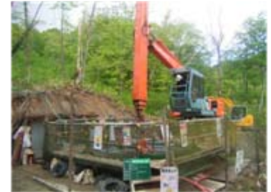
集水井工掘削状況(平成21年6月11日)
