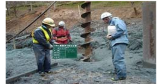
工事状況(セメントミルク注入)
