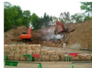
山腹工工事状況(平成21年5月11日)
