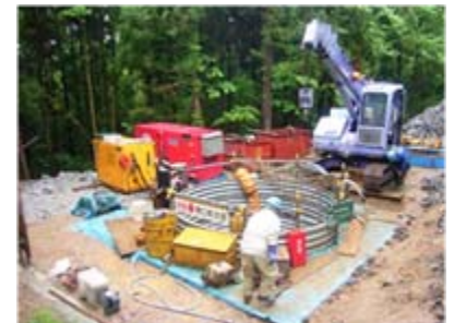
集水井工掘削状況(平成21年6月5日)
