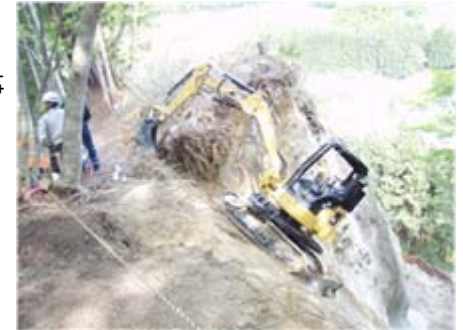
山腹工 工事状況 (平成21年5月11日)
