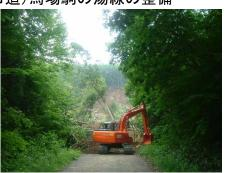
荒砥沢ダム上流部の復旧対策のほか、孤立化した集落(栗原市耕英地区)への通行確保にも資する(市道)馬場駒の湯線の崩土を除去(国有林に接する部分の崩土除去を6月22日完了)
