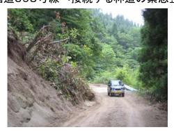
③国道398号線へ接続する林道の緊急整備|・被災した国道398号線の緊急復旧工事のための資材運搬 路として、鎌内国有林林道を緊急に整備(18日より緊急車両 (工事車両)通行中)
