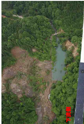
河原小屋沢 河道閉塞状況
