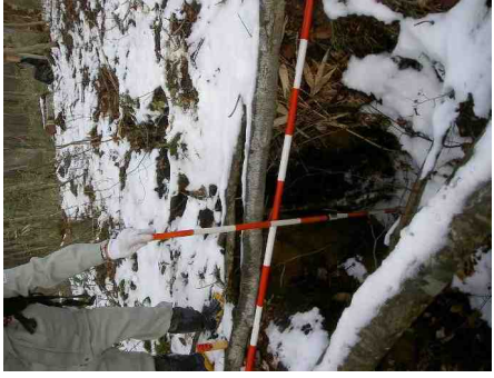
⑤開口した亀裂
