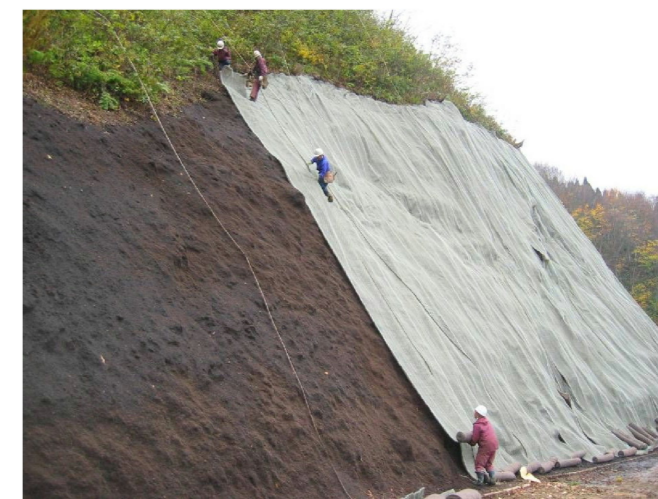
施工時の状況
