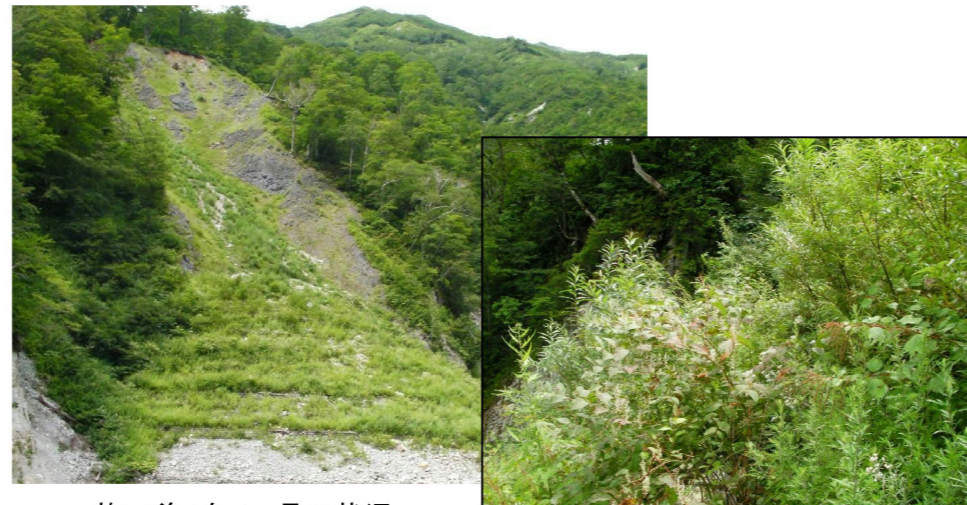
施工後4年9ヶ月の状況
