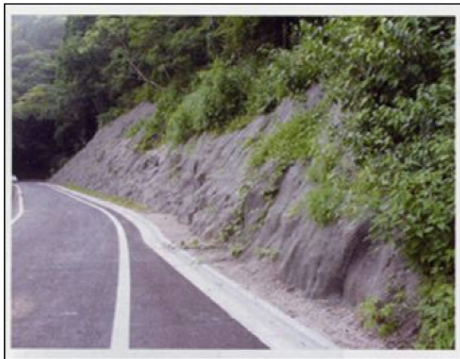
施工後1年3ヶ月の状況
