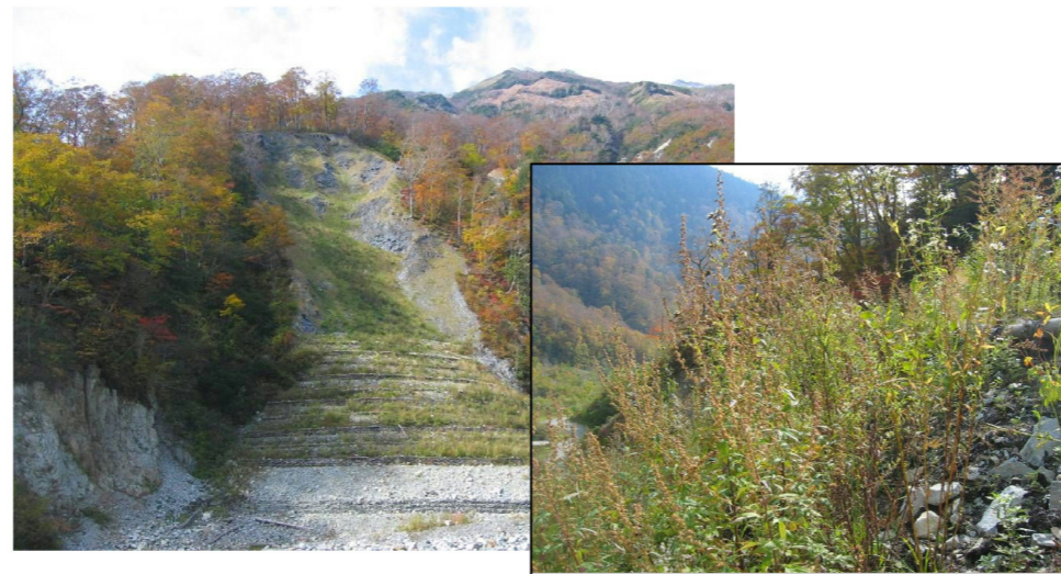
施工後2年の状況
