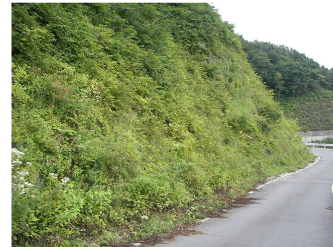
施工後3年10ヶ月の状況
