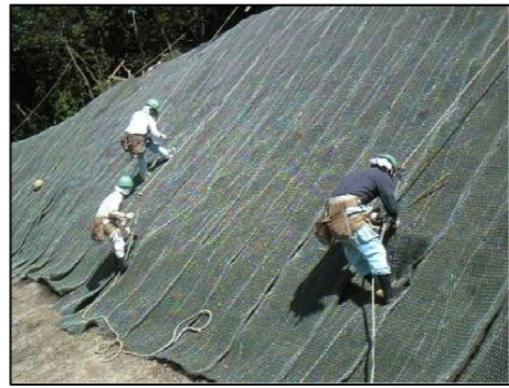
■ 無種子マットの敷設
