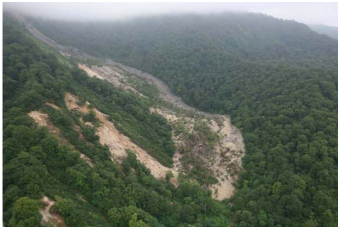
⑦北沢上流の崩壊地からの土砂流出状況
