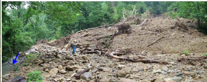
同左の流出土砂, 河道を一部閉塞
