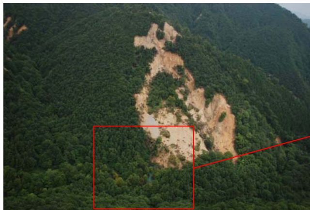
⑥北沢下流部で河道を閉塞している地すべり性崩壊
