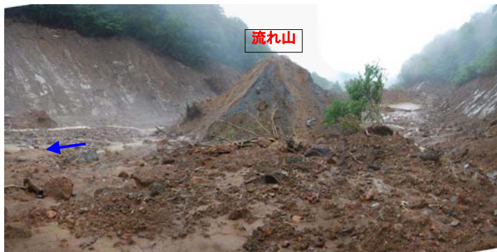
③ 溪床堆積土砂にみられる流れ山地形と兩岸の流過痕跡
