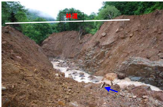
⑤ 流下土砂が停止した狭窄部(林道橋があった位置)
