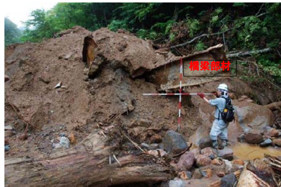
④ 流下土砂の先端部に橋梁の部材がみえる
