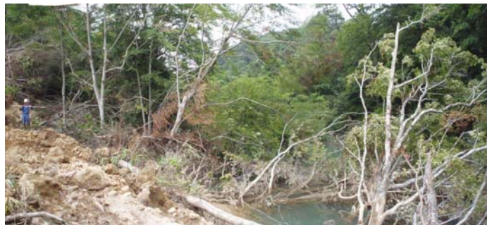
御沢最上流部に形成された土砂ダムと湛水池
