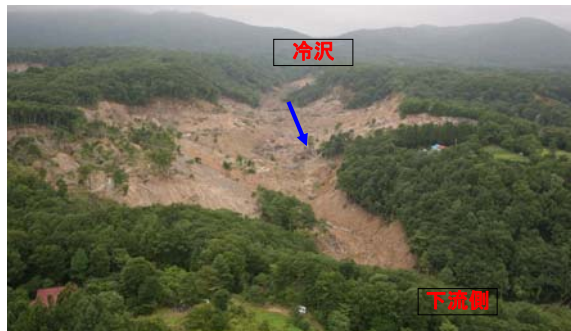
④冷沢崩壊地群(全景)
