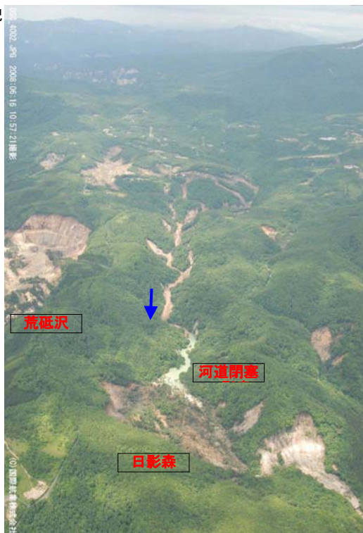
① 耕英地区・御沢流域荒廃状況斜め写真(国際航業撮影)
