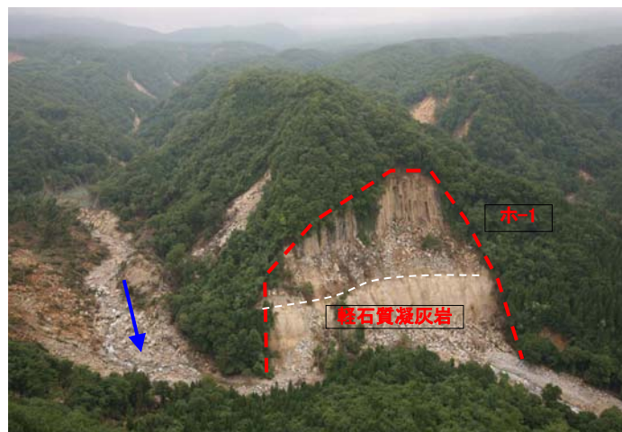
③ 同左 湛水池からの越流と崩壊地 (下流から上流方向を望む)
