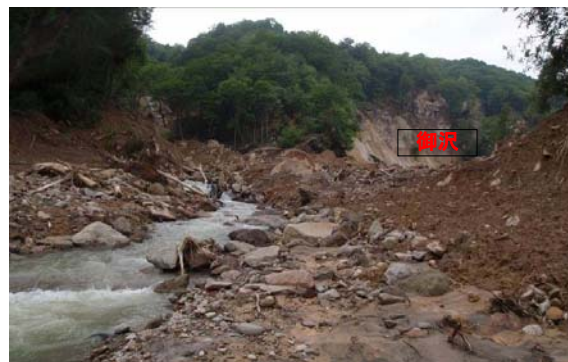
同左 冷沢・御沢合流点の土石流堆積状況
