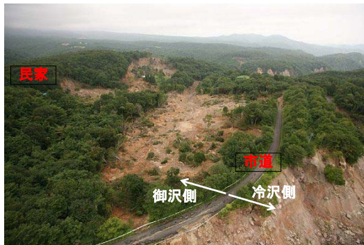
⑦御沢支溪の崩壊状況と市道の被災状況
