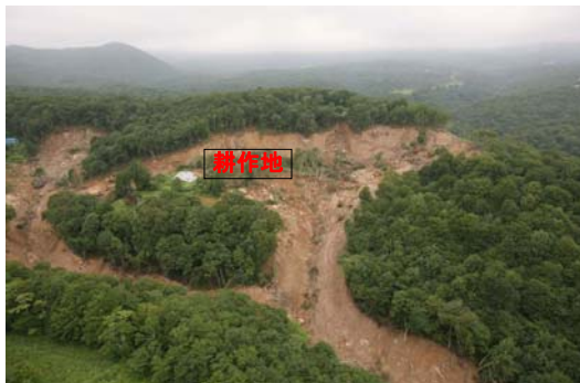
⑦御沢支溪の崩壊状況
