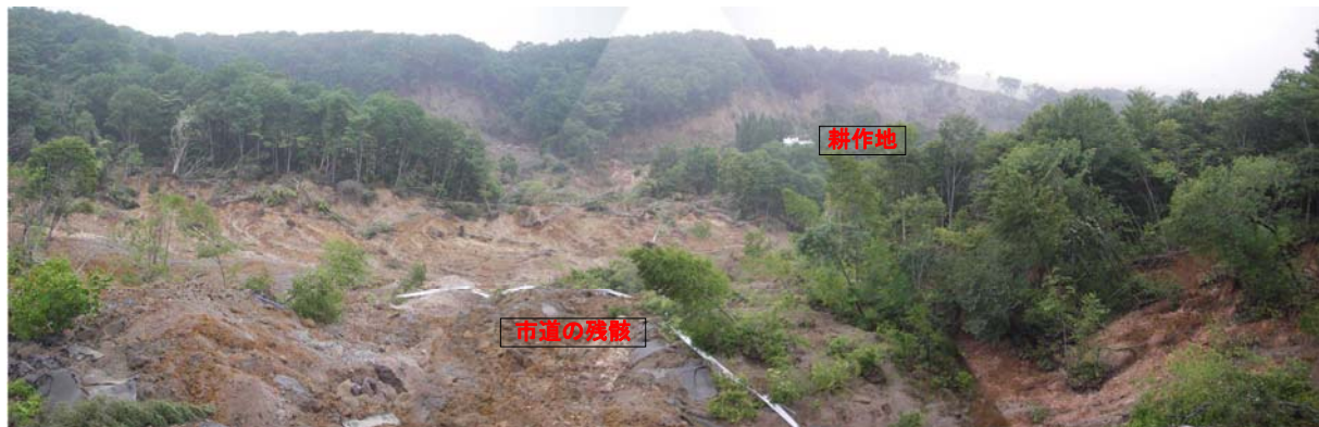
⑦御沢支溪の崩壊状況(不安定土砂堆積状況)
