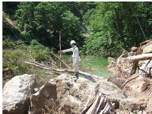
河道閉塞の湛水状況 (7月15日)
