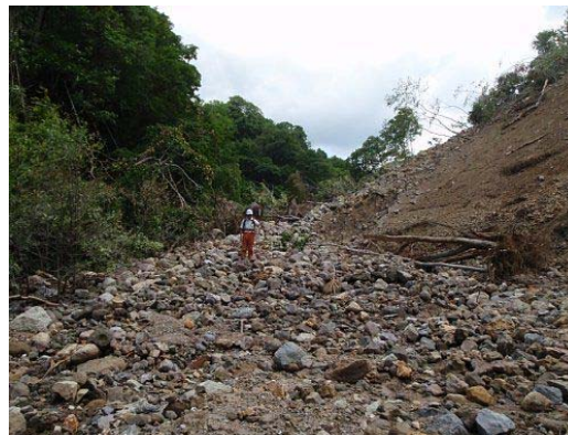
第4河道閉塞(土砂ダム)
