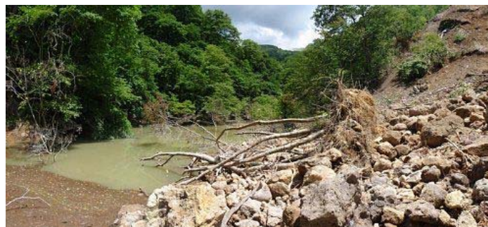
第4河道閉塞 湛水状況 (7月14日)
