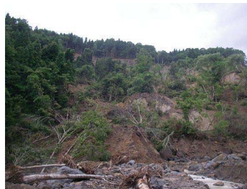
不安定土砂堆積状況
