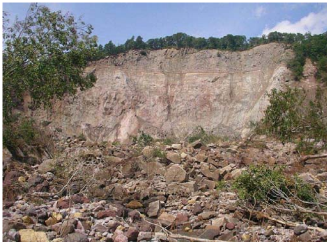
山腹崩壊不安定土塊堆積状況
