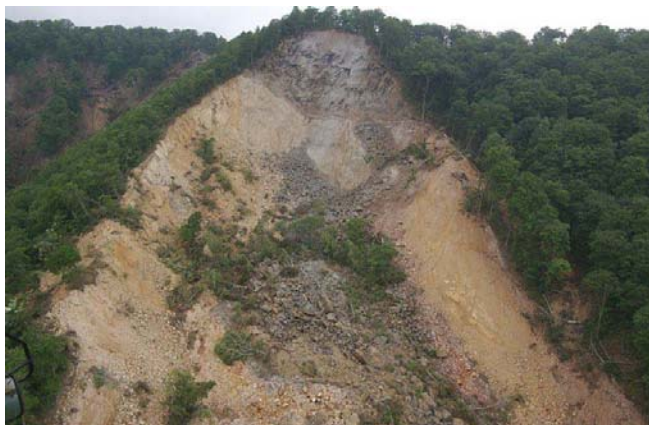
冠頭部落崖(溶結凝灰岩)
