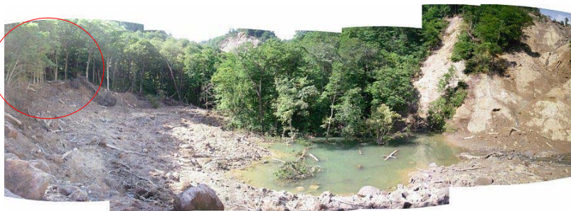
相ノ沢本流・支流合流点の崩壊地末端(本流側) 対岸に粉体が吹き上がり、粘土が樹木に付着
