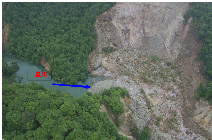
上空写真 湯浜地区河道閉塞 6月25日撮影
