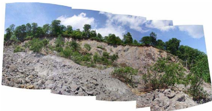
相ノ沢本流・支流合流点の崩壊地滑落崖(不安定土砂堆積状況)
