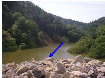
河道閉塞の湛水状況 (7月15日)
