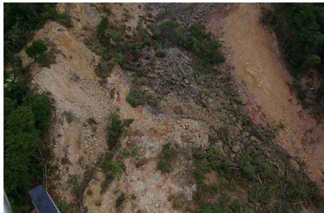
不安定土砂堆積状況
