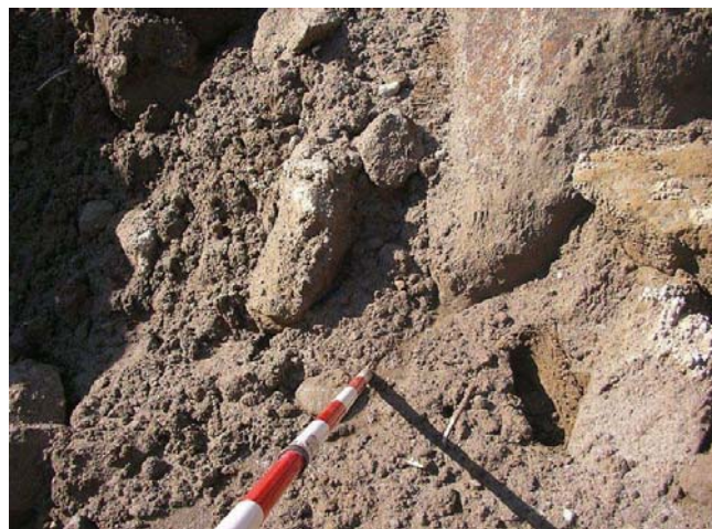
土砂ダム中腹からの湧水
