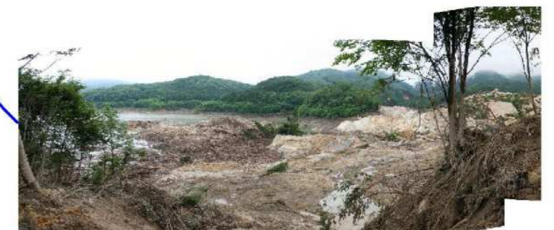
ダム湖へ流出した移動土塊
