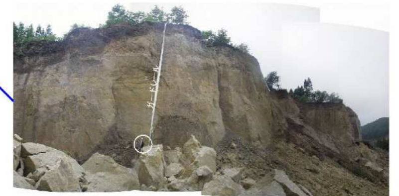
中腹部の滑落崖(ガードレールが垂れ下がり、道路が寸断された)
