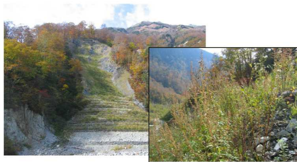
施工後2年の状況
