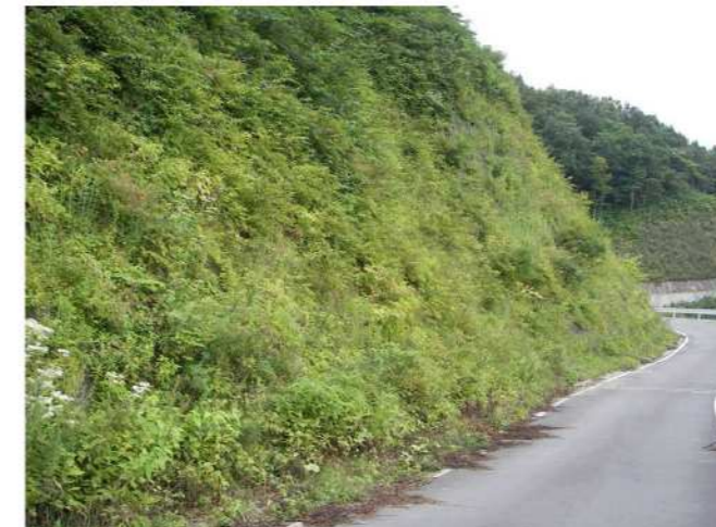
施工後3年10ヶ月の状況
