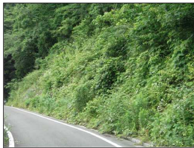
施工後4年3ヶ月の状況
