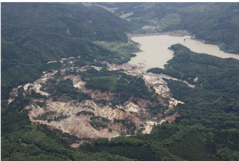
地すべり全景写真(地すべり頭部上空から荒砥沢ダム方向を望む)
