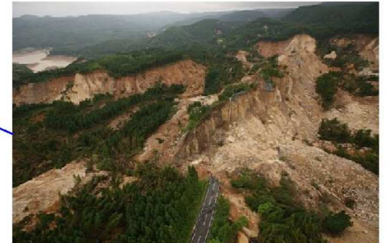
寸断された市道荒砥沢線
