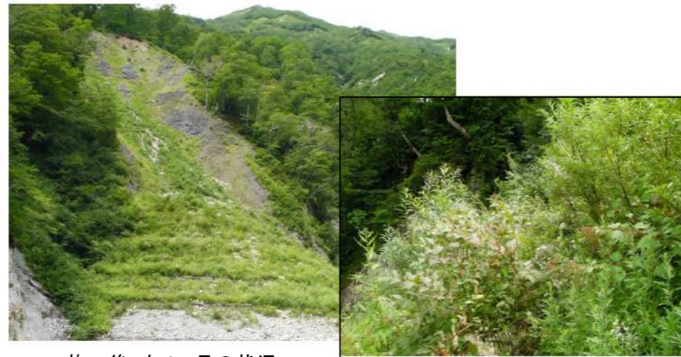
施工後4年9ヶ月の状況
