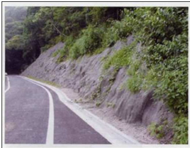
施工後1年3ヶ月の状況
