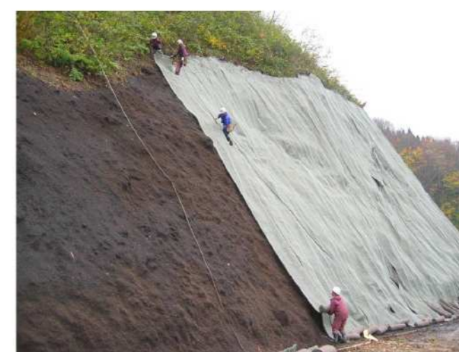
施工時の状況
