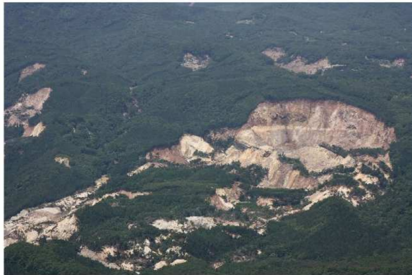
地すべり全景写真(地すべり左側壁側上空から頭部方向を望む)
