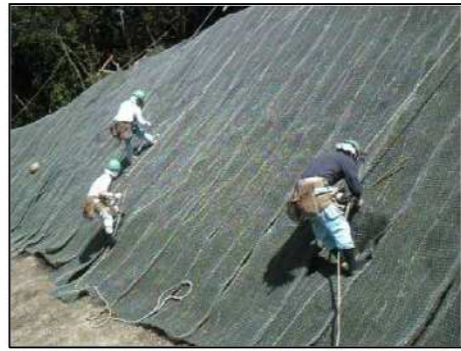
■ 無種子マットの敷設
