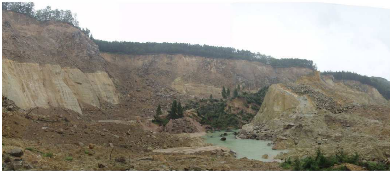
⑥ 滑落崖直下の湛水池
