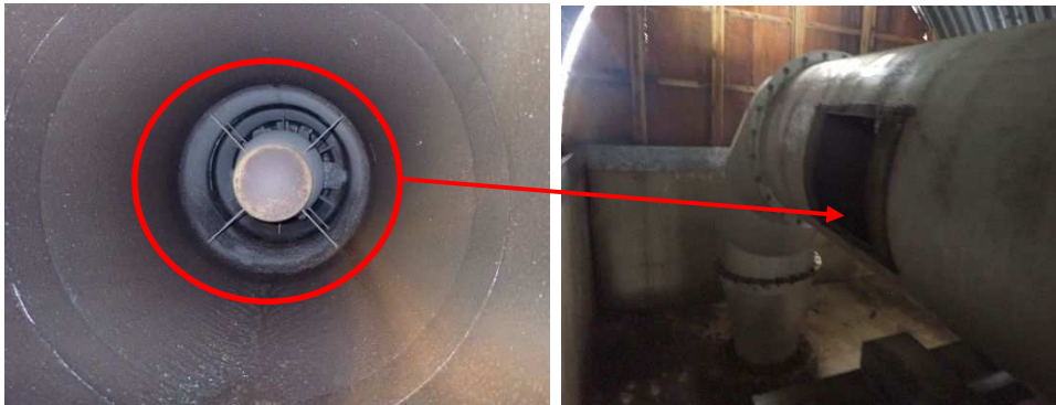
写真：風洞の点検穴から内部を覗いた状況
