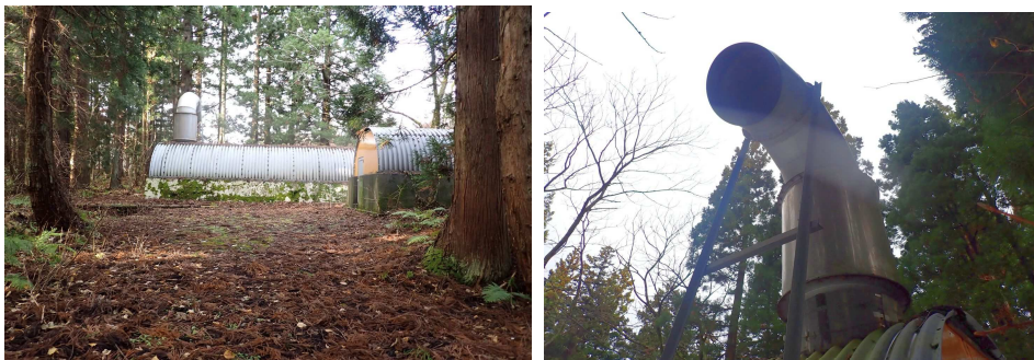
写真：換気ファン建屋と換気坑元
