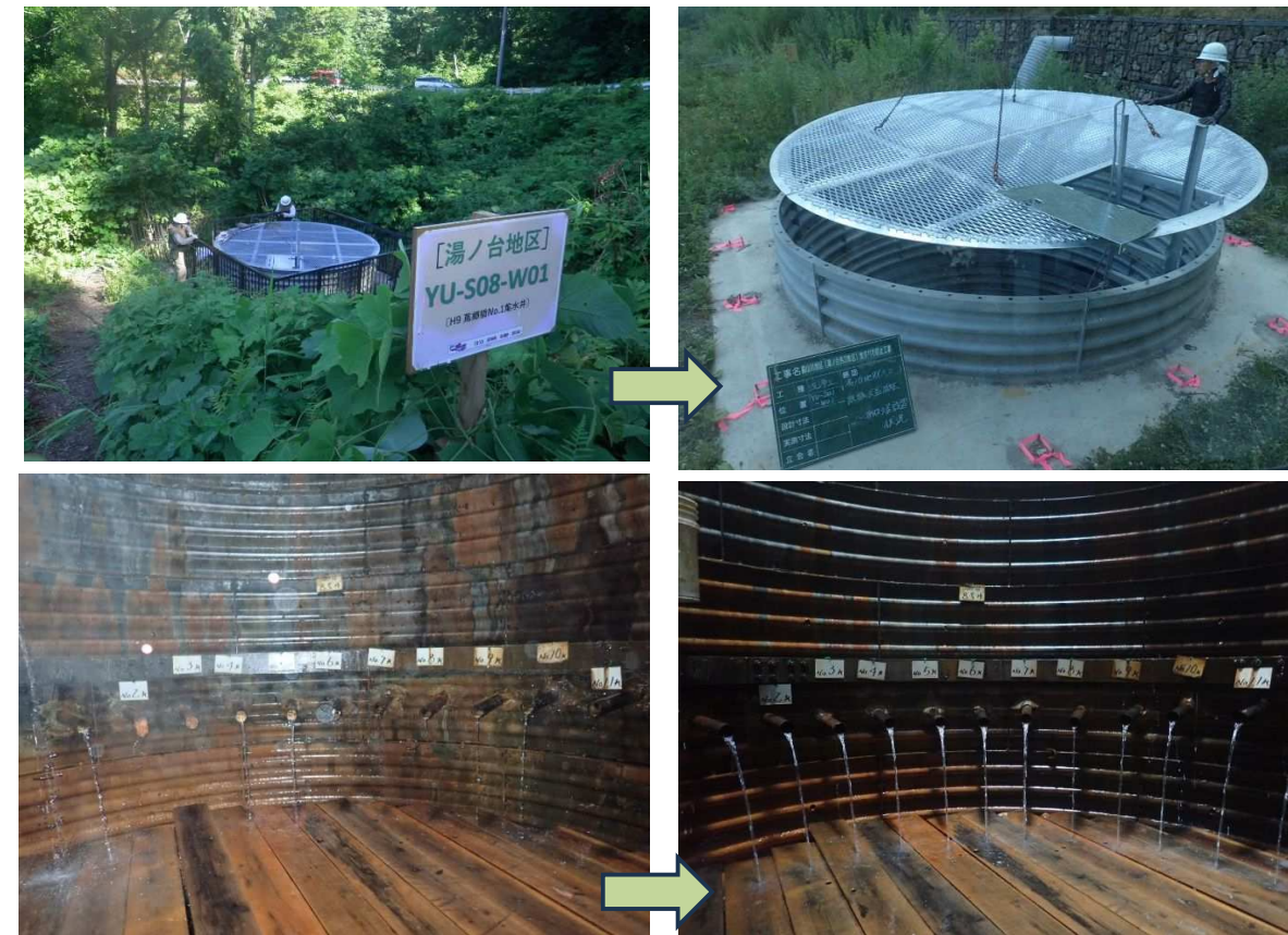
写真 5.19 YU-S08-W01 上（天蓋・防護柵交換）下（集水ボーリング洗浄）
