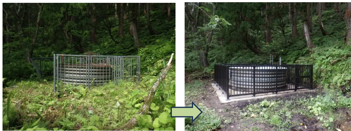
写真 5.4 MI-S04-W02 上 (天蓋・防護柵交換) 下 (集水ボーリング洗浄)
