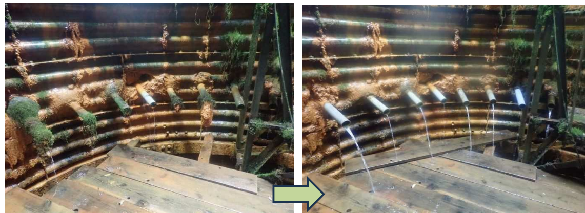
写真 5.8 MI-S04-W01 上（天蓋・防護柵交換）下（集水ポーリング洗浄）
