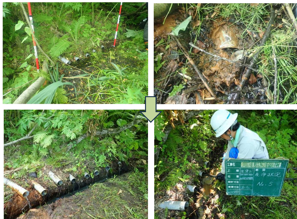
写真 5.17 SA-S01-B01 ボーリング暗渠工洗浄
