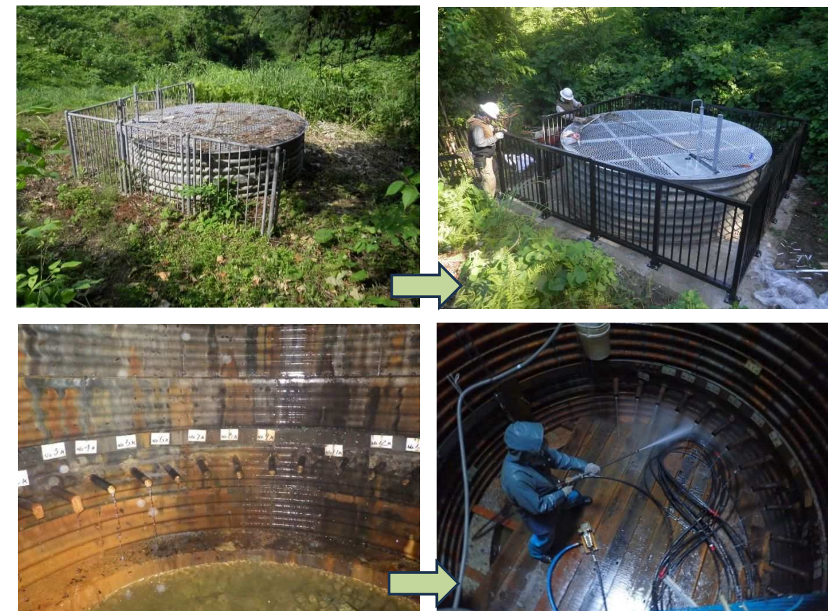
写真 5.20 YU-S08-W02 上（天蓋・防護柵交換）下（集水ボーリング洗浄）
