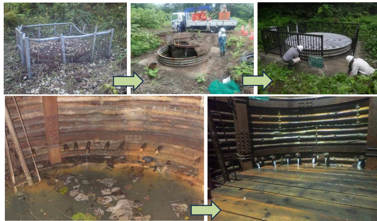
写真 5.18 SA-S01-W08 上（天蓋・防護柵交換）下（集水ボーリング洗浄）
