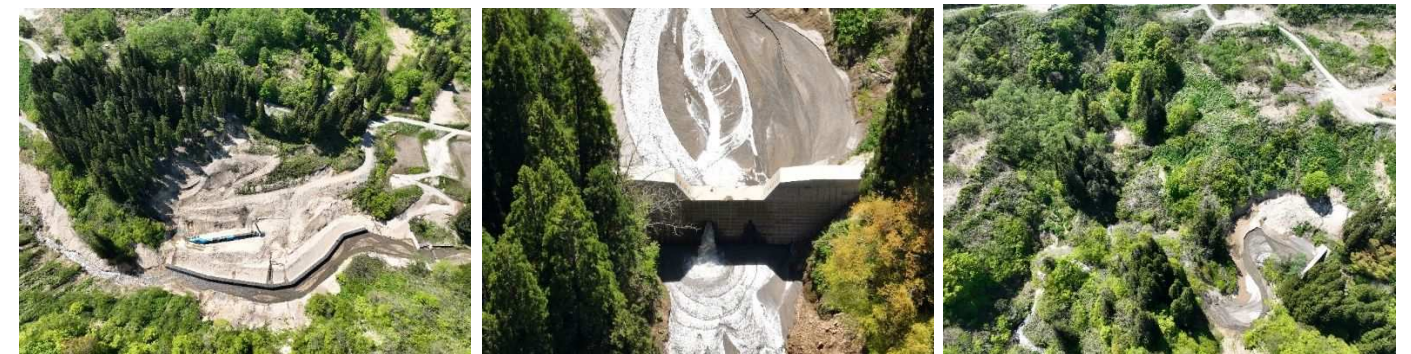
写真 5.35 古水川の治山施設状況（左：R7 護岸工、中：R4 谷止工、右：R4 谷止工上流の堆砂状況）
