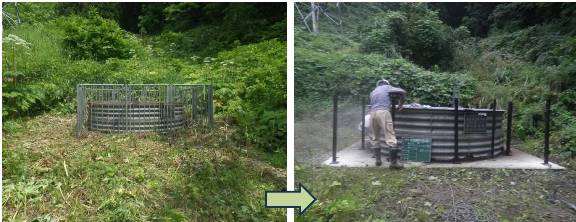
写真 5.8 MI-S04-W01 上（天蓋・防護柵交換）下（集水ポーリング洗浄）
