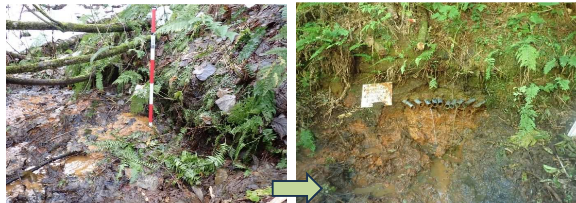
写真 5.25 DO-K-B02(2) (左: R4 施設点検時、右: R7 ポーリング暗渠工洗浄後)
