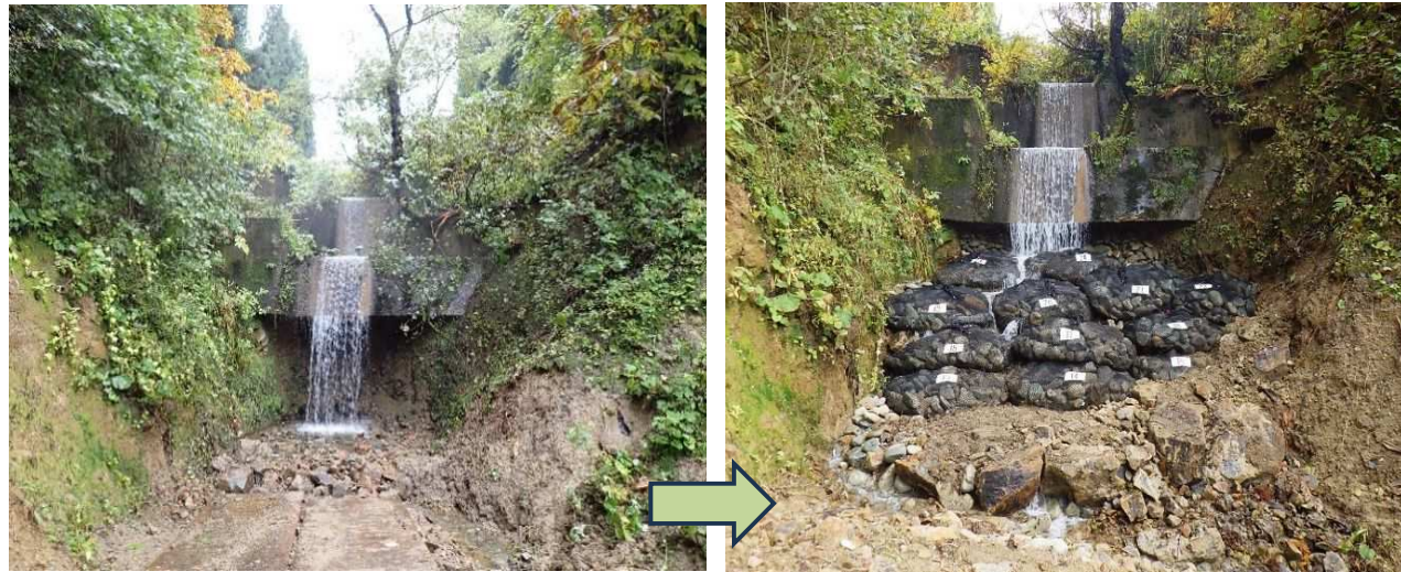
写真 5.31 DO-K-T01 (左: R4 施設点検時、右: R7 補修工事実施)
