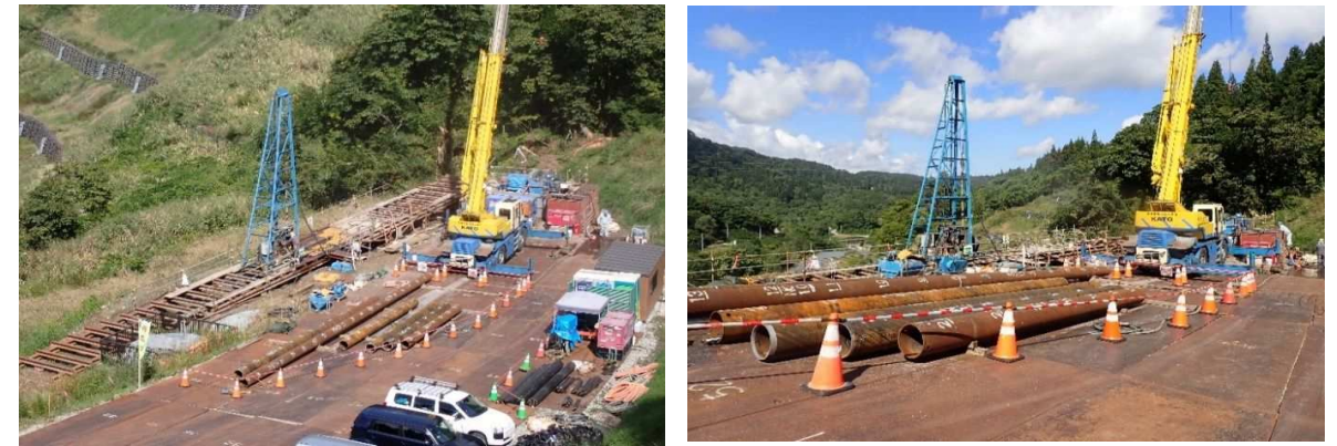
写真 5.10 MI-S07-1 鋼管杭工施工状況（R8年度完成予定）
