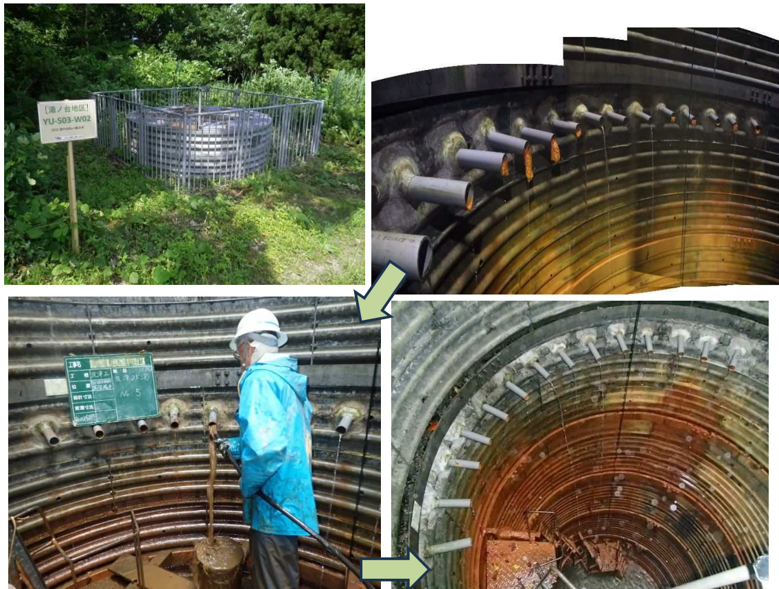
写真 5.22 YU-S03-W02 上(全景)下(集水ボーリング洗浄)
