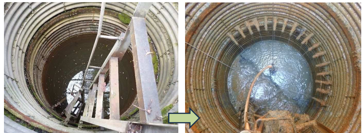
写真 5.6 MI-S05-W01 上 (天蓋・防護柵交換) 下 (土砂浚渫、集水ボーリング洗浄)
