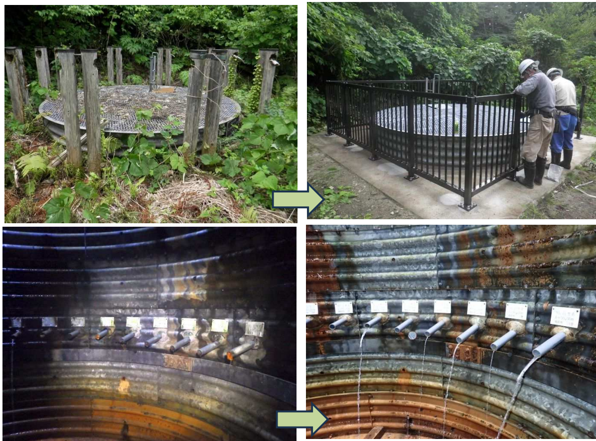
写真 5.16 SA-S01-W03 上（天蓋・防護柵交換）下（集水ボーリング洗浄）
