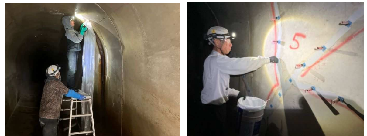
写真 5.12 排水トンネル補修作業状況（令和7年度に補修工実施）
