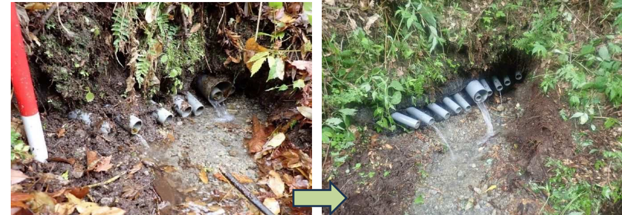
写真 5.28 DO-K-B09 (左: R4 施設点検時、右: R7 ポーリング暗渠工洗浄後)
