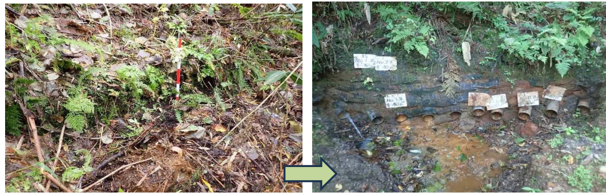
写真 5.24 DO-K-B02(1) (左: R4 施設点検時、右: R7 ポーリング暗渠工洗浄後)
