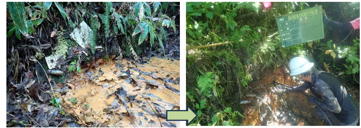
写真 5.27 DO-K-B07 (左: R4 施設点検時、右: R7 ポーリング暗渠工洗浄後)
