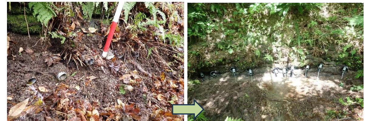
写真 5.29 DO-K-B12 (左: R4 施設点検時、右: R7 ポーリング暗渠工洗浄後)
