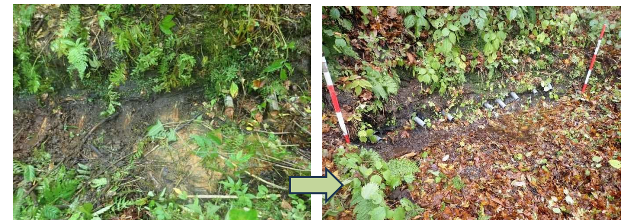
写真 5.30 DO-K-B19 (左: R4 施設点検時、右: R7 ポーリング暗渠工洗浄後)
