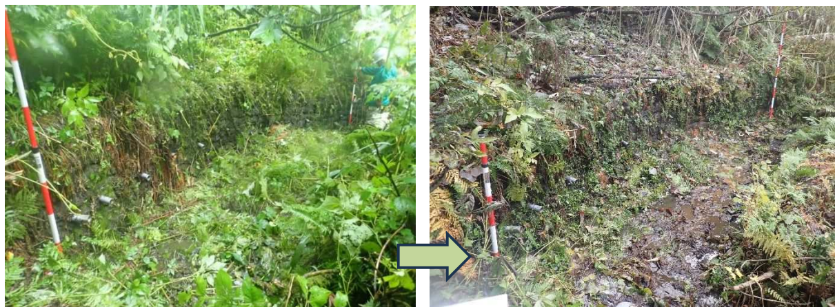
写真 5.26 DO-K-B05 (左: R4 施設点検時、右: R7 ポーリング暗渠工洗浄後)
