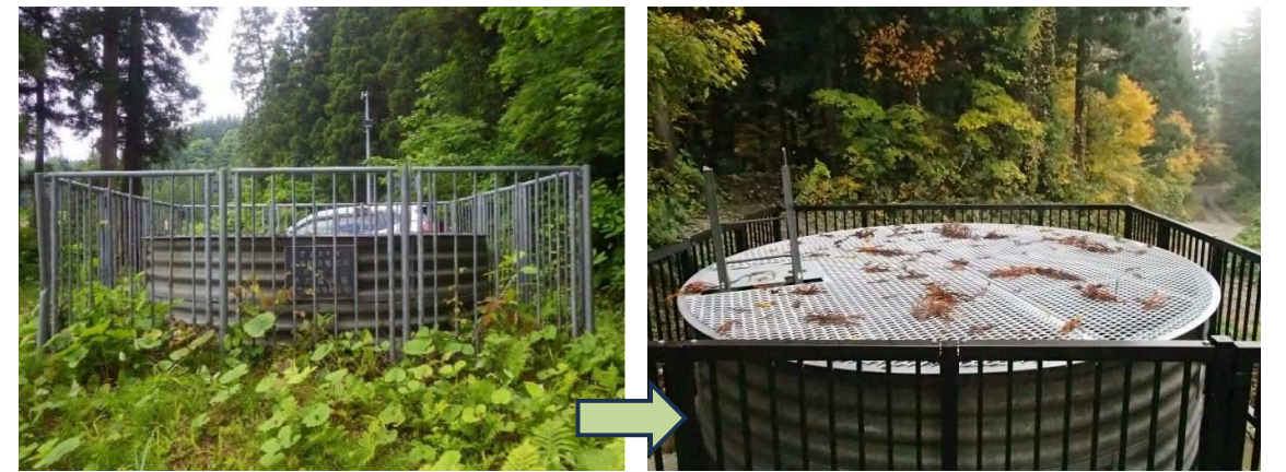
写真 5.6 MI-S05-W01 上 (天蓋・防護柵交換) 下 (土砂浚渫、集水ボーリング洗浄)
