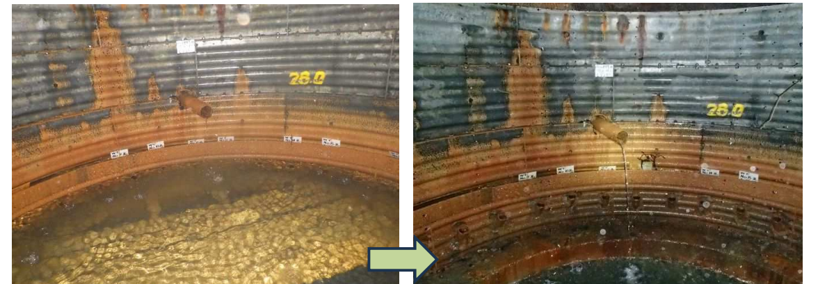
写真 5.7 MI-S07-W01 上 (天蓋・防護柵交換) 下 (集水ボーリング洗浄：湛水解消)
