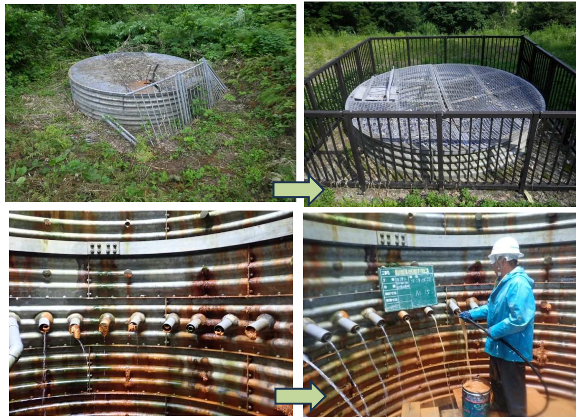
写真 5.21 YU-S01-W01 上(天蓋交換)下(集水ボーリング洗浄)
