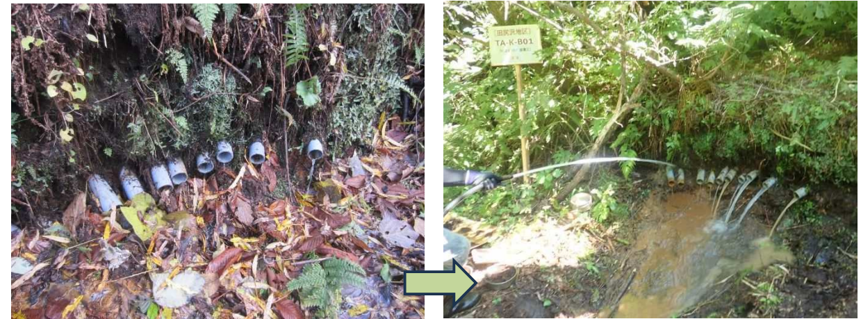
写真 5.32 TA-K-B01 (左: R4 施設点検時、右: R7 ボーリング暗渠工洗浄後)
