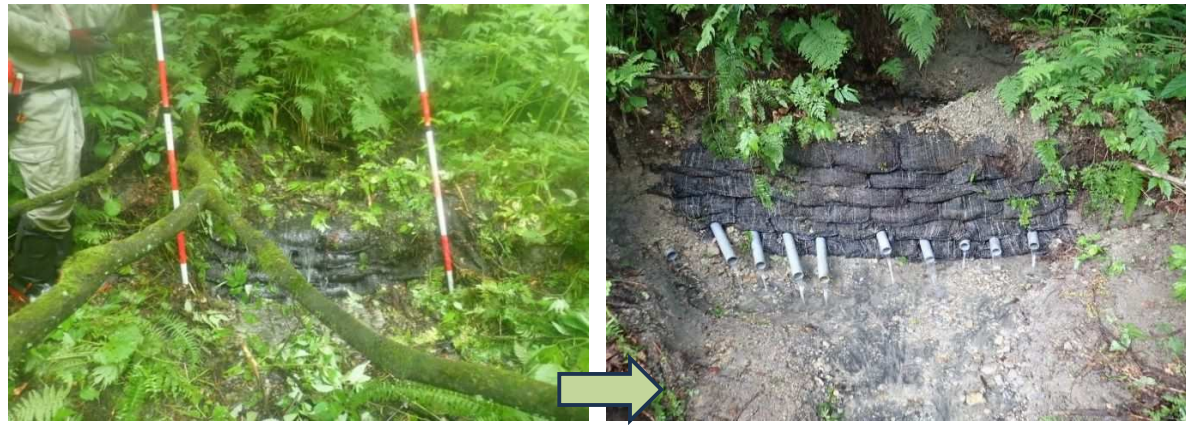
写真 5.23 DO-K-B14 (左: R4 施設点検時、右: R7 ポーリング暗渠工洗浄後)
