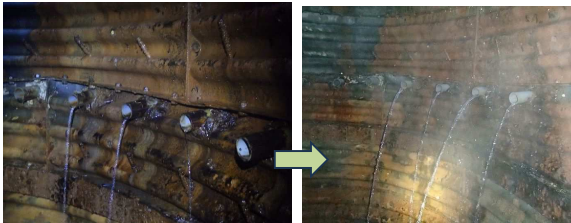
写真 5.4 MI-S04-W02 上 (天蓋・防護柵交換) 下 (集水ボーリング洗浄)
