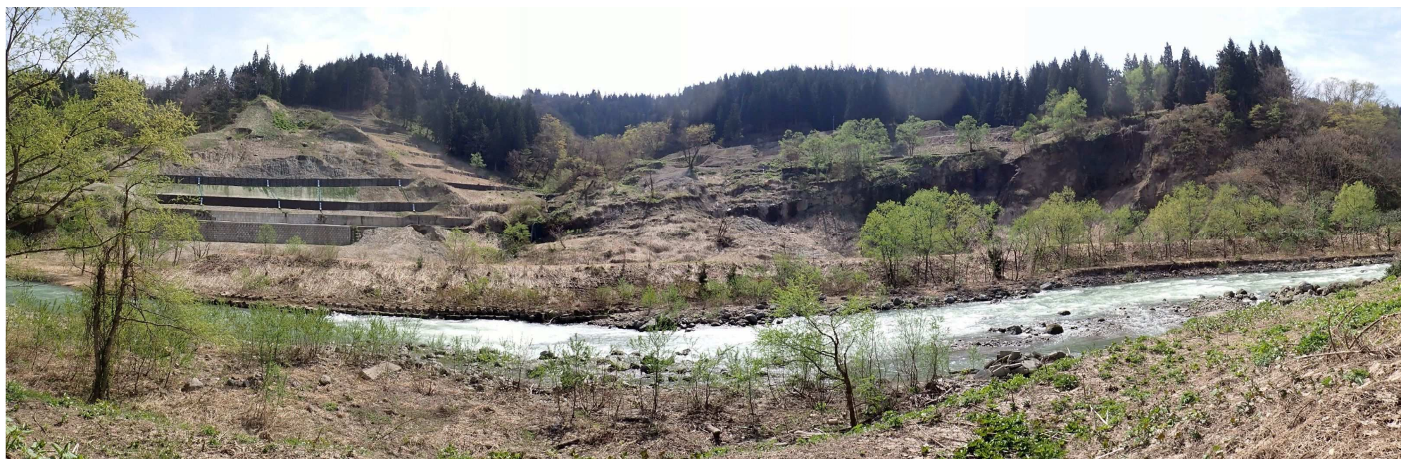
写真 2 銅山川対岸（左岸）からの遠望（上：平成8年撮影、下：令和6年撮影）：銅山川の河道がバイパス化され、MI-S06ブロックの山腹工で整備され、MI-S07ブロック末端に崩土の堆積が確認される
