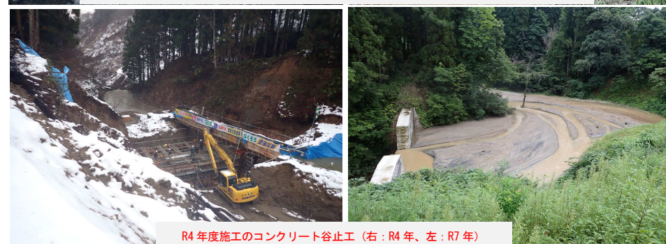
R4 年度施工のコンクリート谷止工 (右 : R4 年、左 : R7 年)
