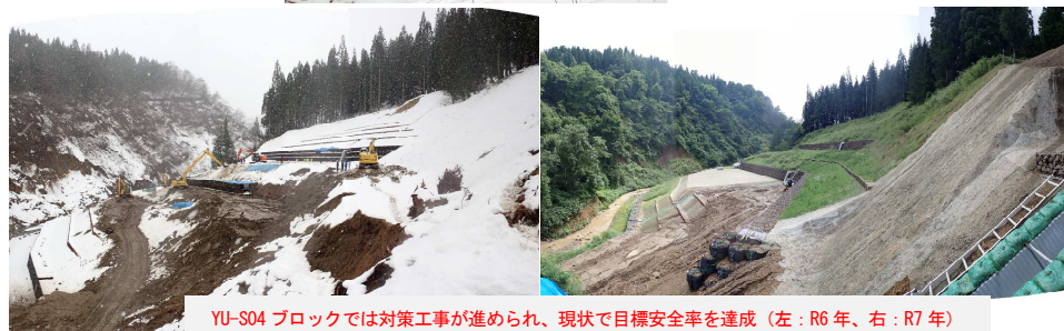
YU-S04 ブロックでは対策工事が進められ、現状で目標安全率を達成 (左 : R6 年、右 : R7 年)
