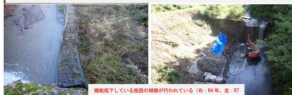
R4 年度施工のコンクリート谷止工の堆砂効果は大きく、約 300m 上流で 4.0m 近く溪床が上昇し、勾配の緩和が図られている
