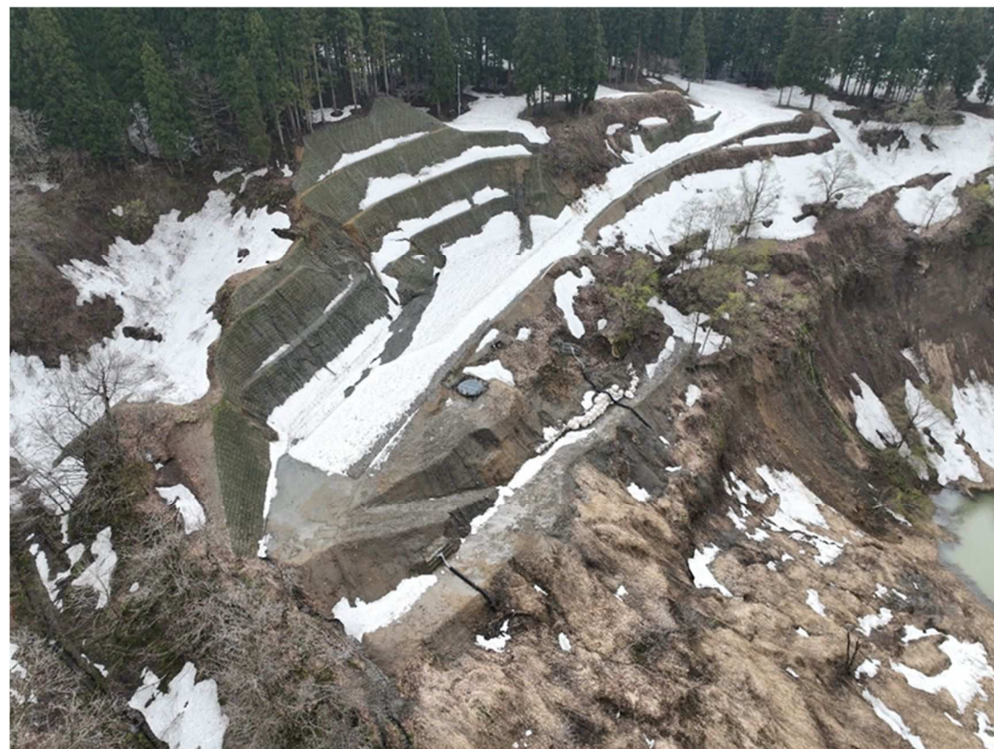
写真 4.3 MI-S07-1 ブロック全景写真 (R7.4.18 撮影)
