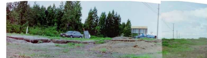
19 国道 458 号沿いに発生した陥没帯 (写真奥が斜面下方)
