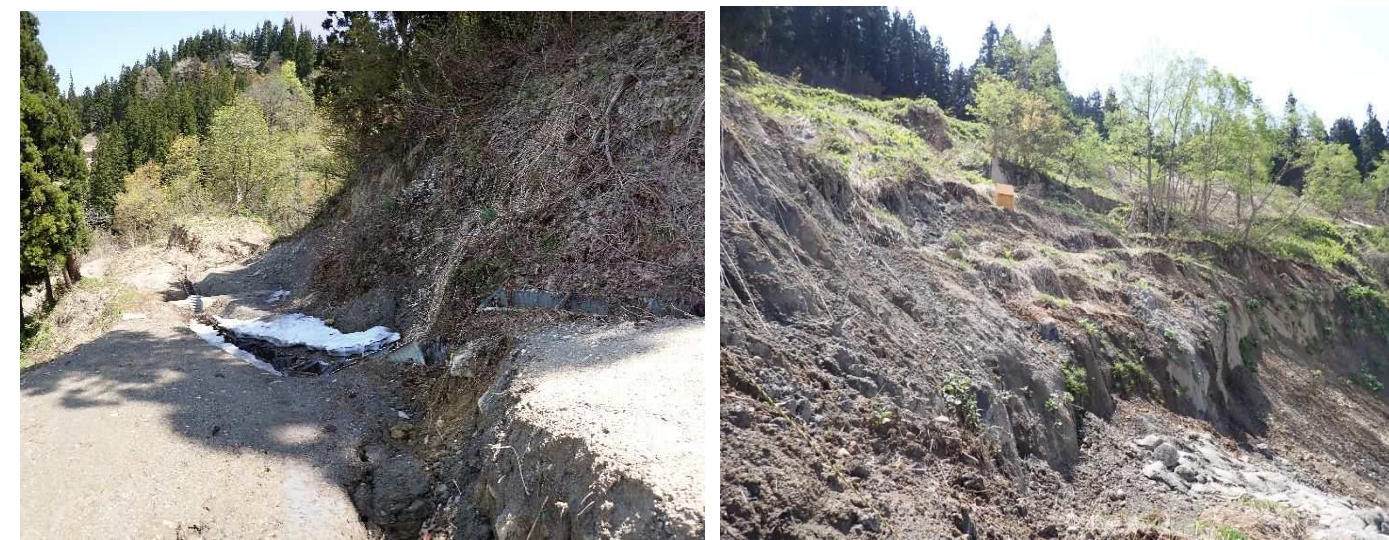
写真 4.5 MI-S07 ブロック 地すべり変状拡大時の斜面状況 (R5.5月撮影)
