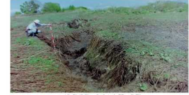
17 陥没帯に発生した開口亀裂
