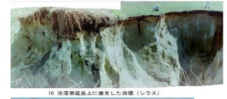
16 滑溜帯延長上に発生した崩壊 (シラス)
