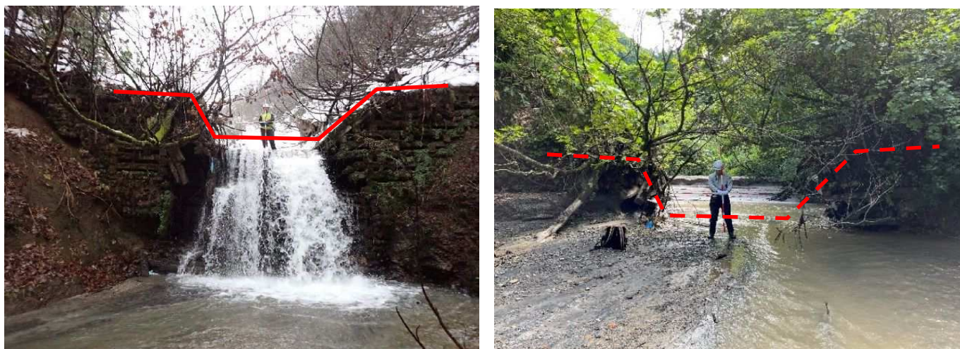
写真 5.1 令和 4 年度谷止工の堆砂により水通し部まで埋没する既設谷止工（FU-K-5）
