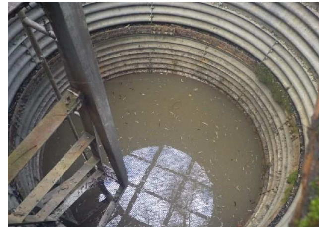
写真 2.6 MI-S05-W01 左（集水井の湛水） 右（H26点検時には確認された排水ボーリング出口が埋設）
