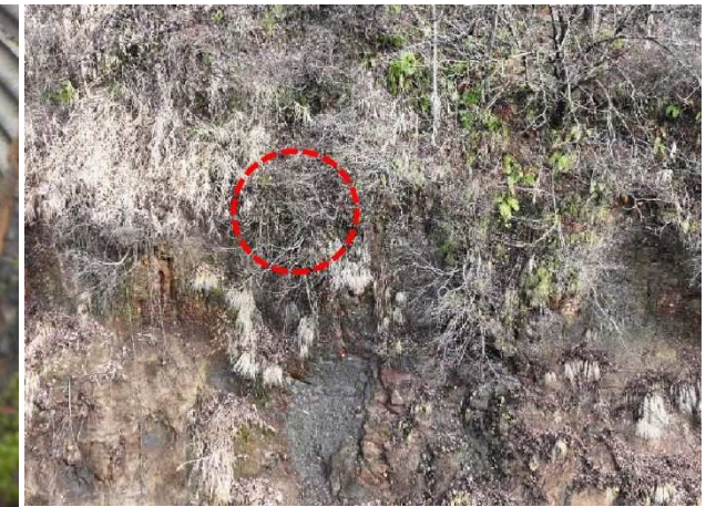
写真 2.6 MI-S05-W01 左（集水井の湛水） 右（H26点検時には確認された排水ボーリング出口が埋設）
