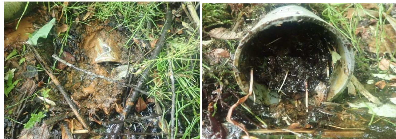
写真 2.13 SA-S01-B01 左（地上集水ボーリング孔口の土砂による閉塞） 右（孔内の閉塞）
