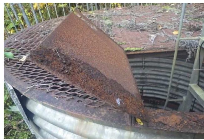
写真 2.4 MI-S04-W02 左（防護柵の破損） 右（天蓋の腐植と破損）
