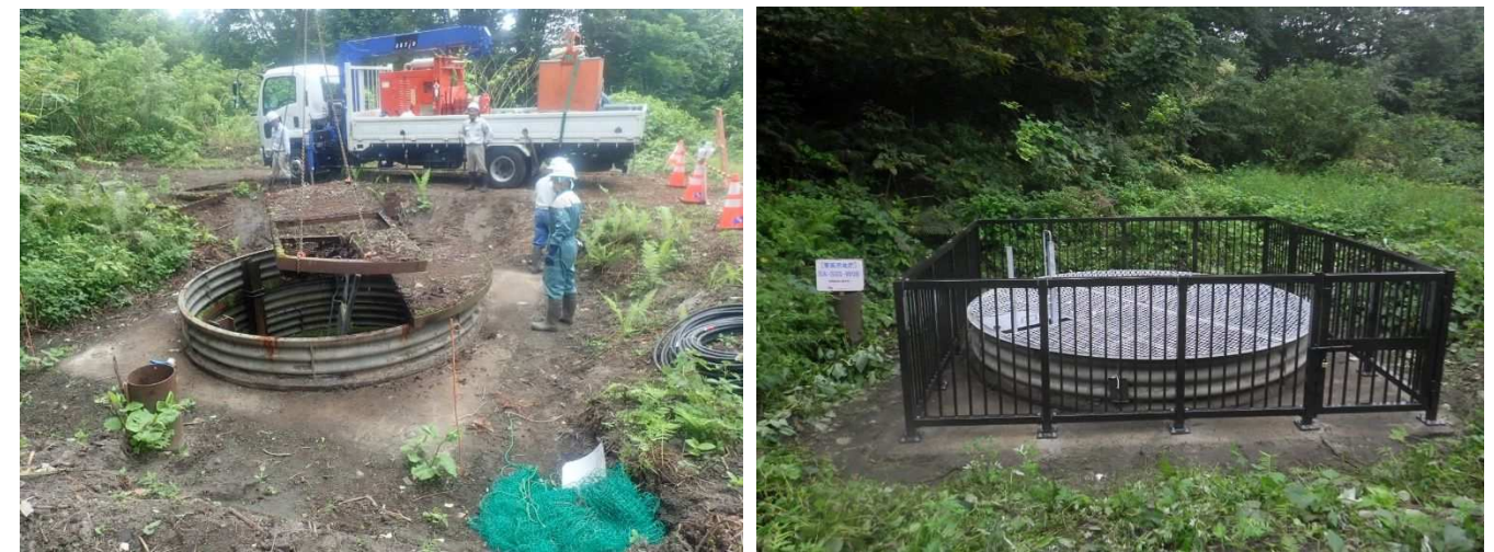
写真 2.15 SA-S01-W08 改修工事 左（施工中）、右（完成）
