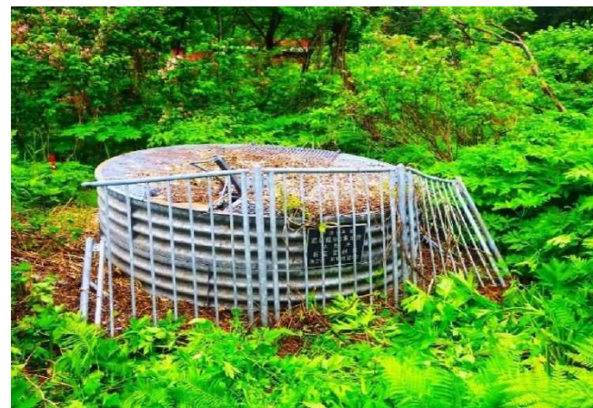
写真 2.16 YU-S08-W01 左 (防護柵の破損) 右 (集排水ボーリングは健全)
