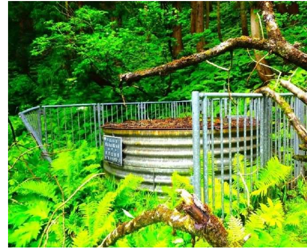
写真 2.5 MI-S04-W03 左（防護柵の破損） 右（天蓋の腐植と破損）
