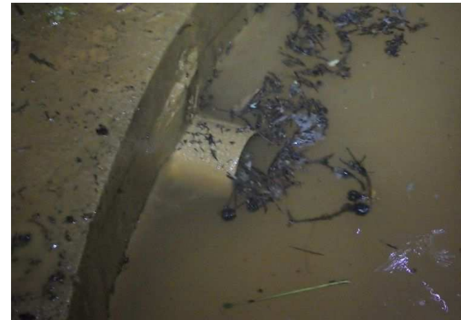
写真 2.19 YU-S03-W02 左 (排水ボーリング呑み口の閉塞) 右 (集水ボーリングのスケールによる閉塞)
