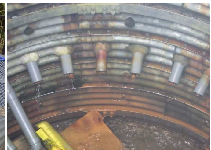
写真 2.20 YU-S01-W01 左 (雪圧による天蓋、トラップ用手すりの変形) 右 (スケールによる閉塞率 50%以上が 10 本/18 本中)
