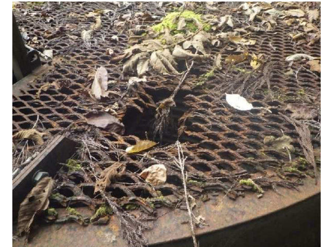
写真 2.5 MI-S04-W03 左（防護柵の破損） 右（天蓋の腐植と破損）
