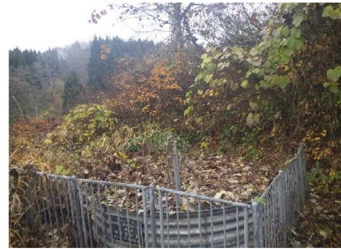
写真 2.18 YU-S08-W02 左 (防護柵の破損) 右 (集排水ボーリング、閉塞率 90 が 2 本/17 本中)
