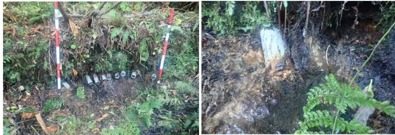
写真 2.31 TA-K-B01 閉塞率 20%が 2 本/10 本中、ほかも保孔管底部の土砂の堆積が H26 より増加
