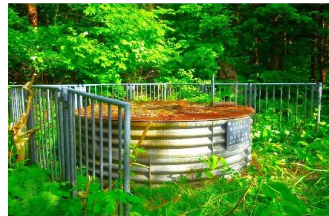
写真 2.4 MI-S04-W02 左（防護柵の破損） 右（天蓋の腐植と破損）
