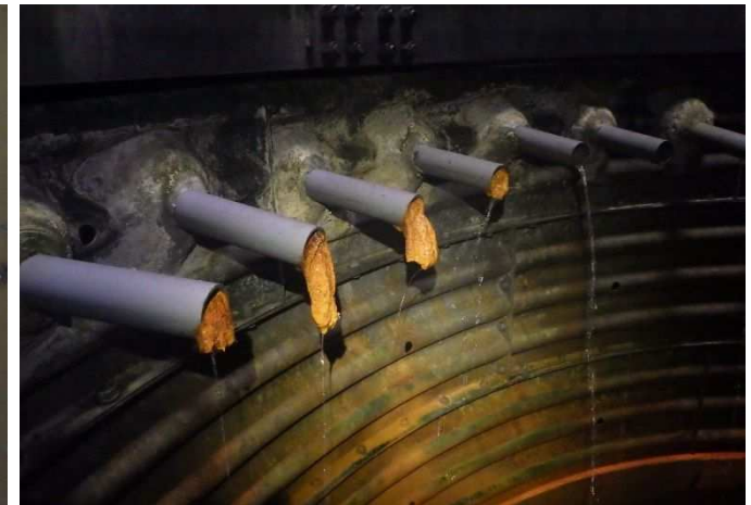
写真 2.19 YU-S03-W02 左 (排水ボーリング呑み口の閉塞) 右 (集水ボーリングのスケールによる閉塞)
