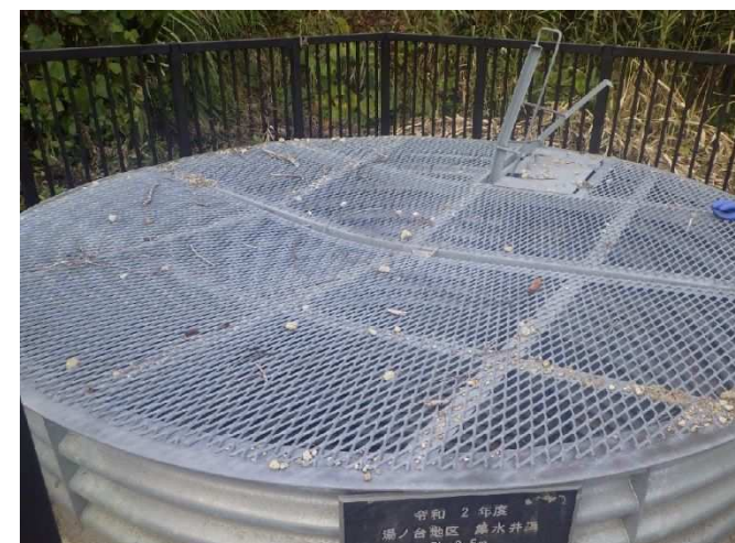
写真 2.20 YU-S01-W01 左 (雪圧による天蓋、トラップ用手すりの変形) 右 (スケールによる閉塞率 50%以上が 10 本/18 本中)
