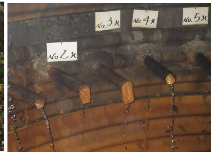
写真 2.18 YU-S08-W02 左 (防護柵の破損) 右 (集排水ボーリング、閉塞率 90 が 2 本/17 本中)
