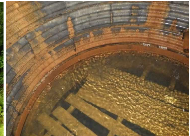
写真 2.7 MI-S07-W01 左（防護柵の破損） 右（井内湛水）
