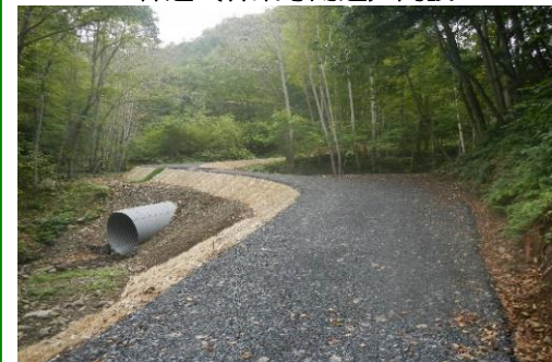
林道（林業専用道）開設
