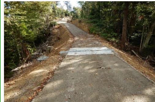
林道（林業専用道）開設
