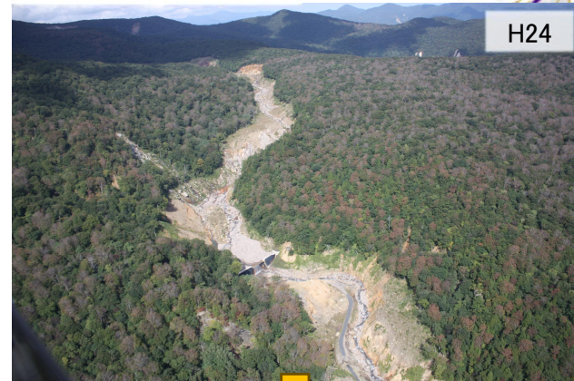
【①ドゾウ沢 復旧状況】
