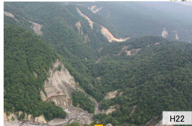
【①湯ノ倉 復旧状況】
