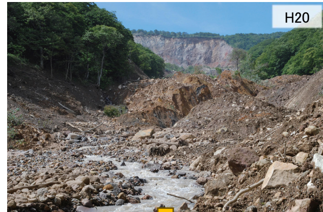
【①産女川上流 溪間工整備状況】
