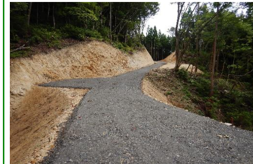
林道（林業専用道）開設
