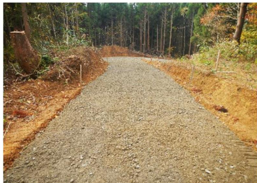
林道（林業専用道）開設
