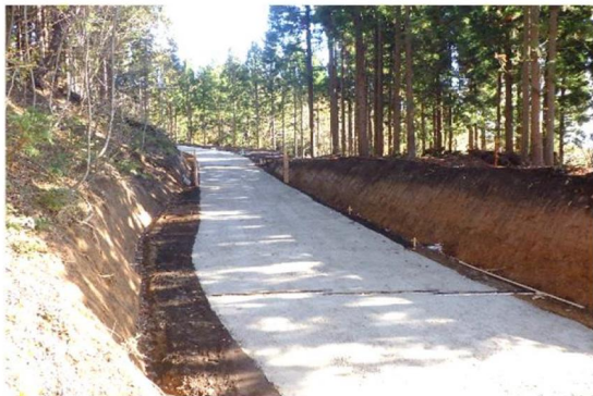
林道（林業専用道）開設
