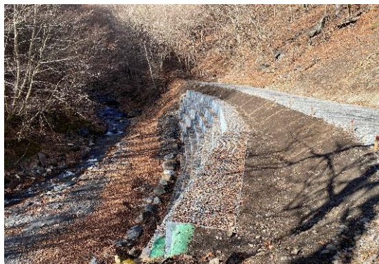
林道（林業専用道）開設
