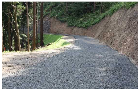
林道（林業専用道）新設
