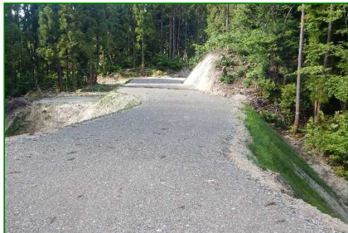
林道（林業専用道）新設
