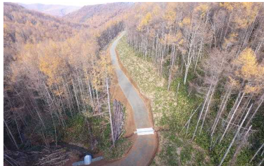
薮川(北の沢)林道(林業専用道)
