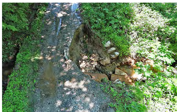
南山林道災害時（空撮）
