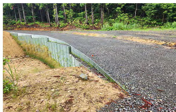
土橋沢林道災害復旧後
