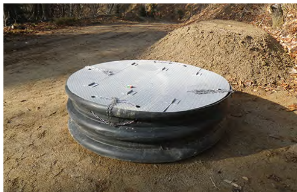
残渣処理施設設置状況
