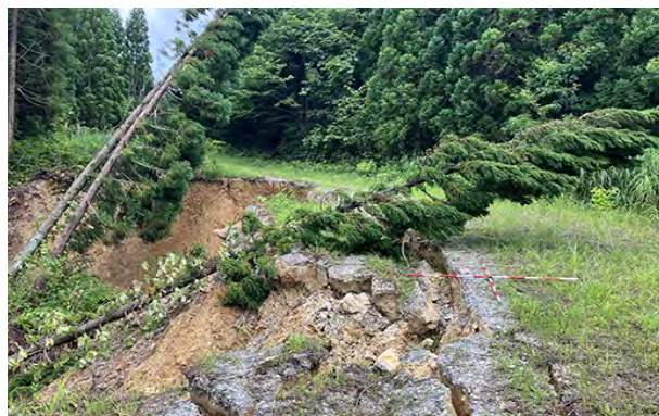
土橋沢林道災害時
