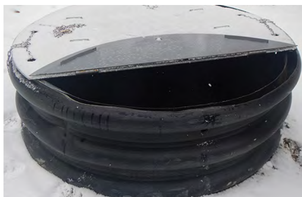
転落防止・熊対策・不法投棄防止のため蓋を設置
