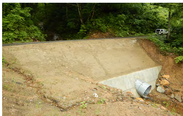
南山林道災害復旧後
