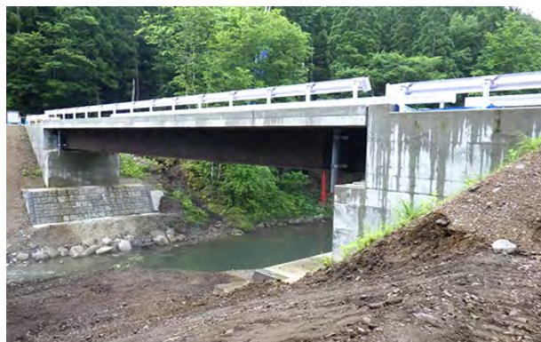
林道改良工事の写真（橋梁架けかえ）
