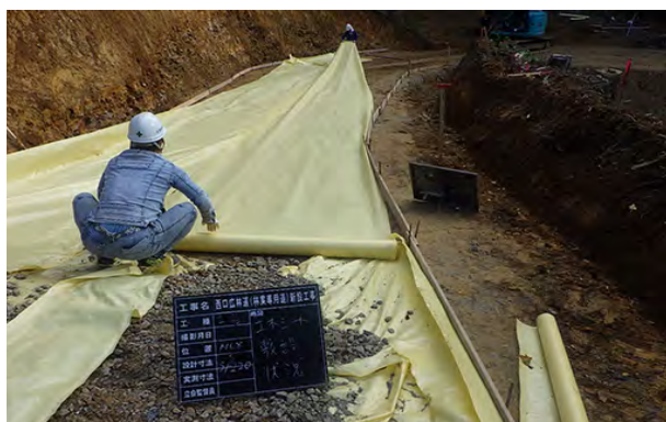
土木シートの敷設状況
