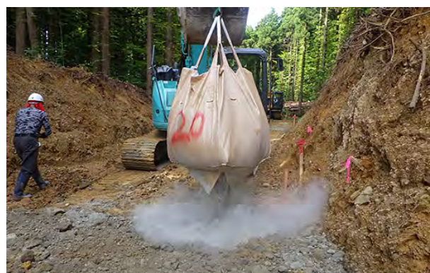
セメント系固化材の投入状況
