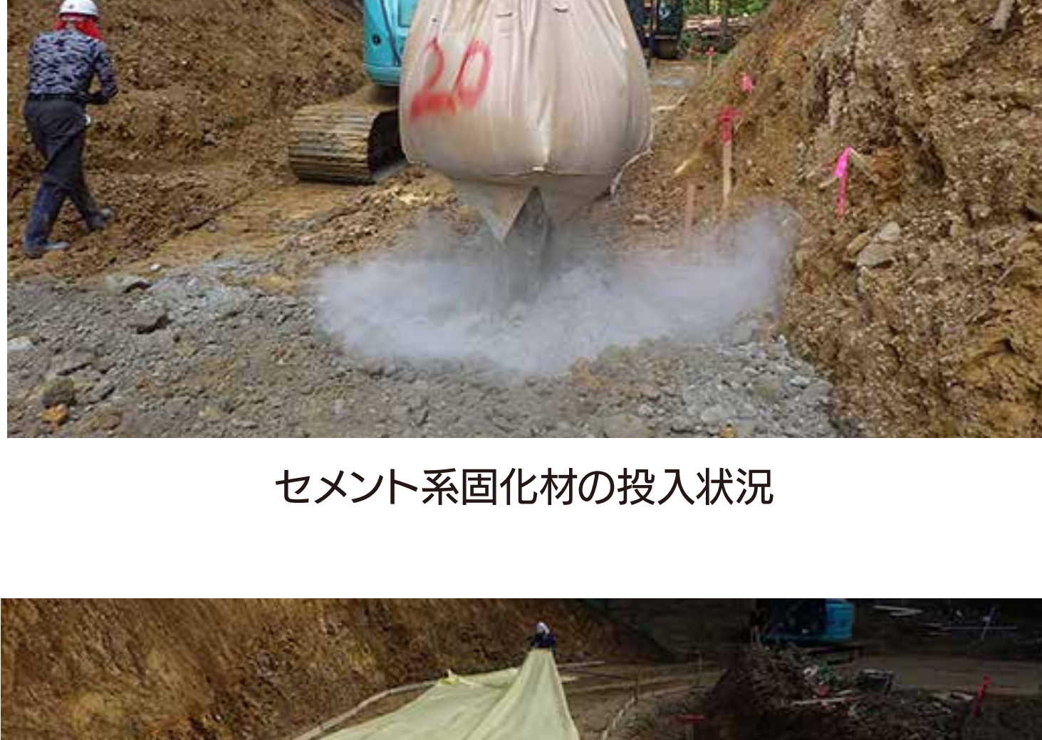
セメント系固化材の投入状況
