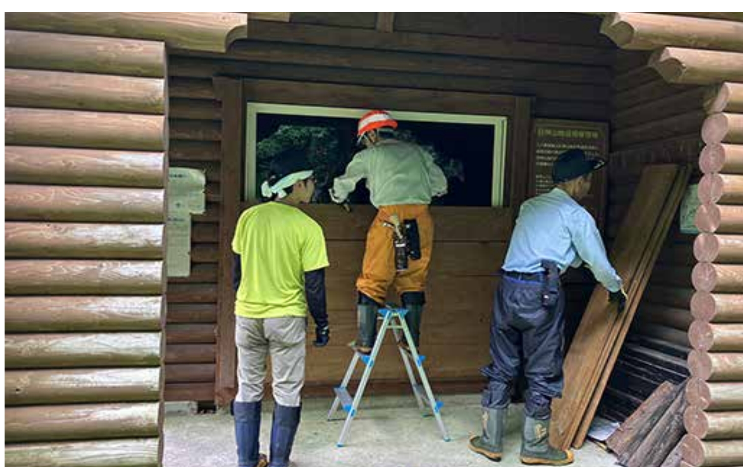
白神山地巡視管理棟の整備 (小岳)
