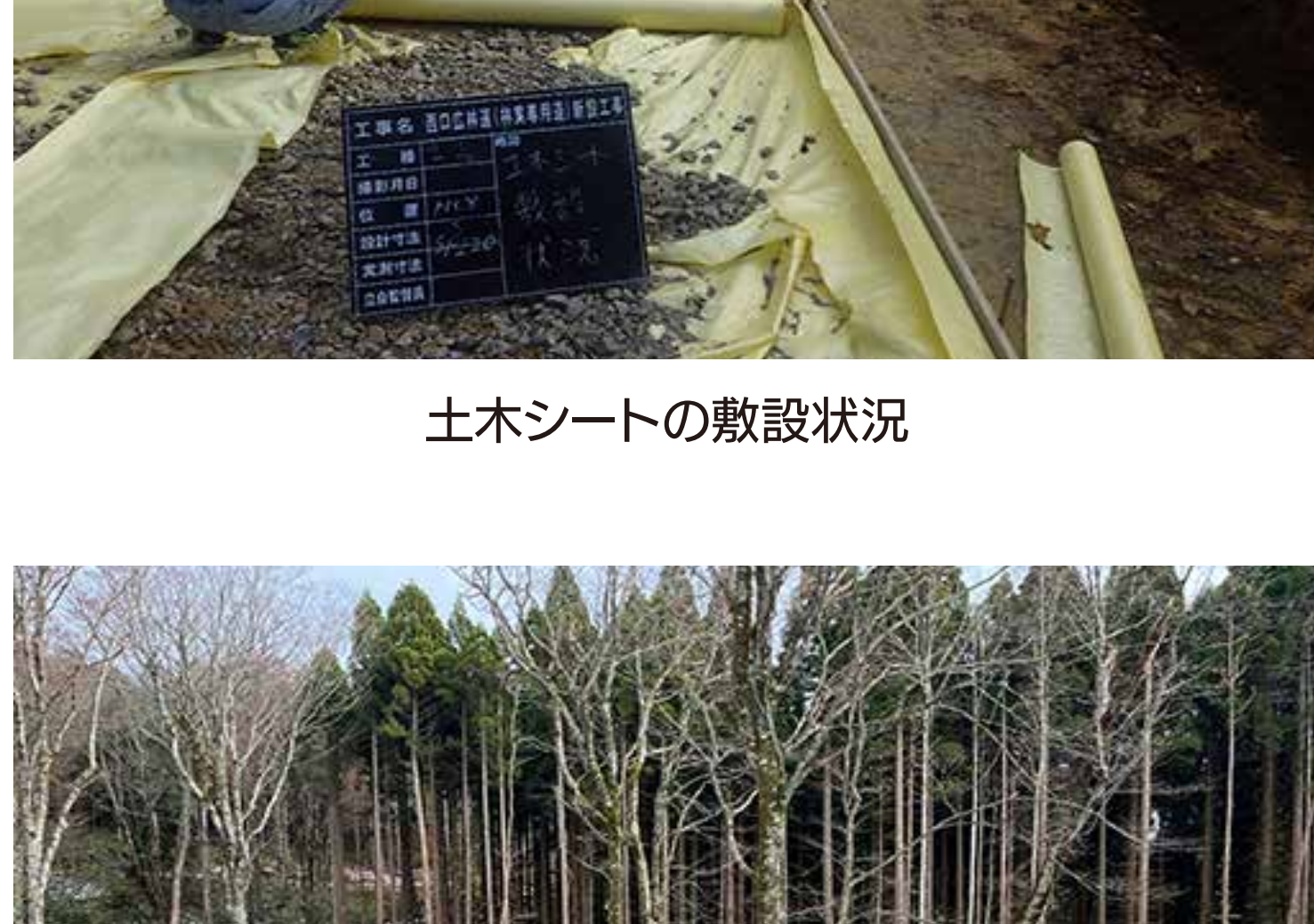
土木シートの敷設状況
