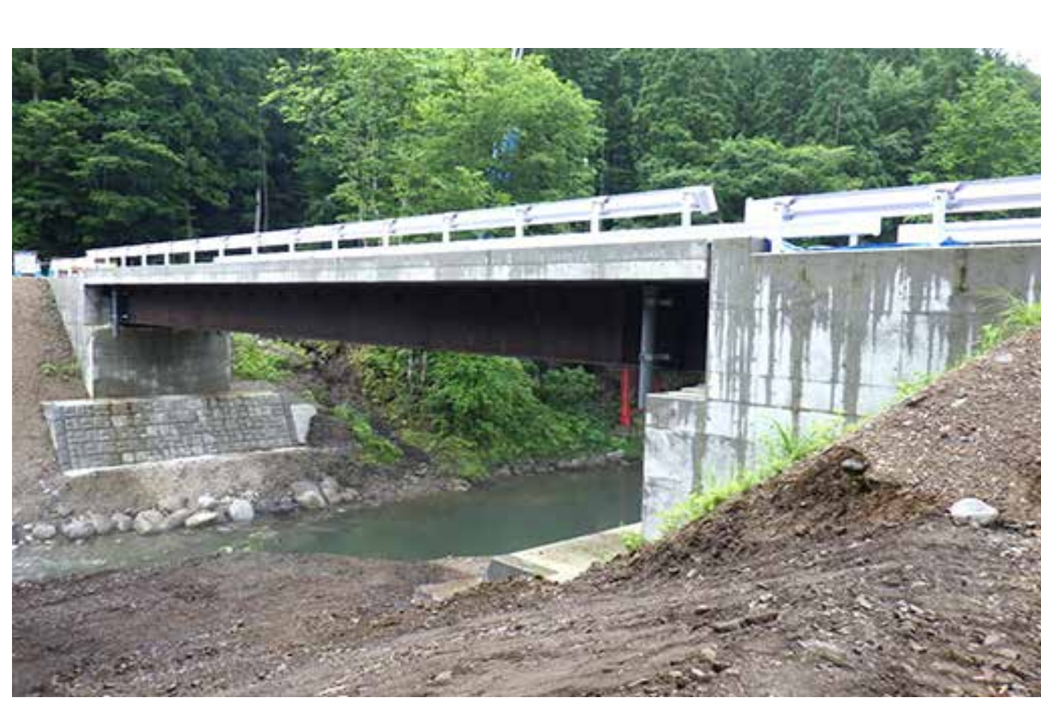
林道改良工事の写真（橋梁架けかえ）
