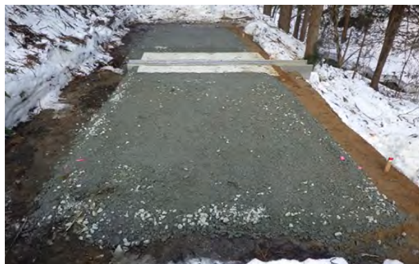
令和5年度被災 芦沢林道復旧後
