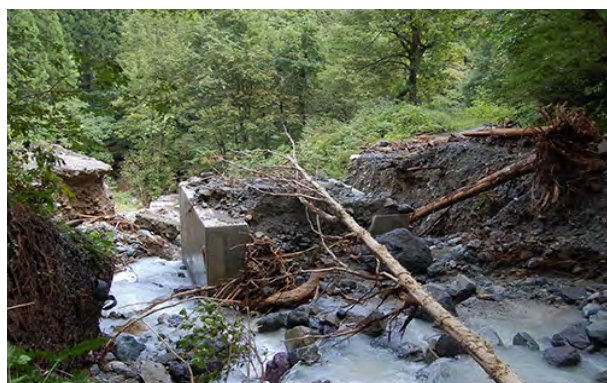
令和7年度被災 小岱倉林道被災時
