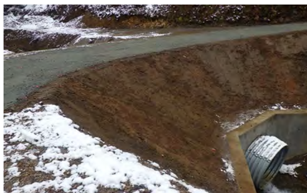
令和6年度被災 孫沢林道復旧後
