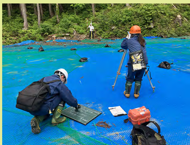
盛土の出来形確認 実施状況
