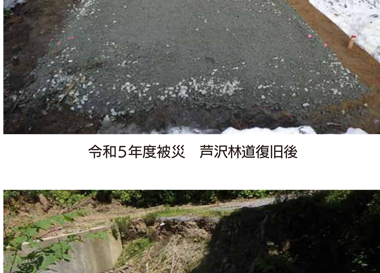
令和5年度被災 芦沢林道復旧後
