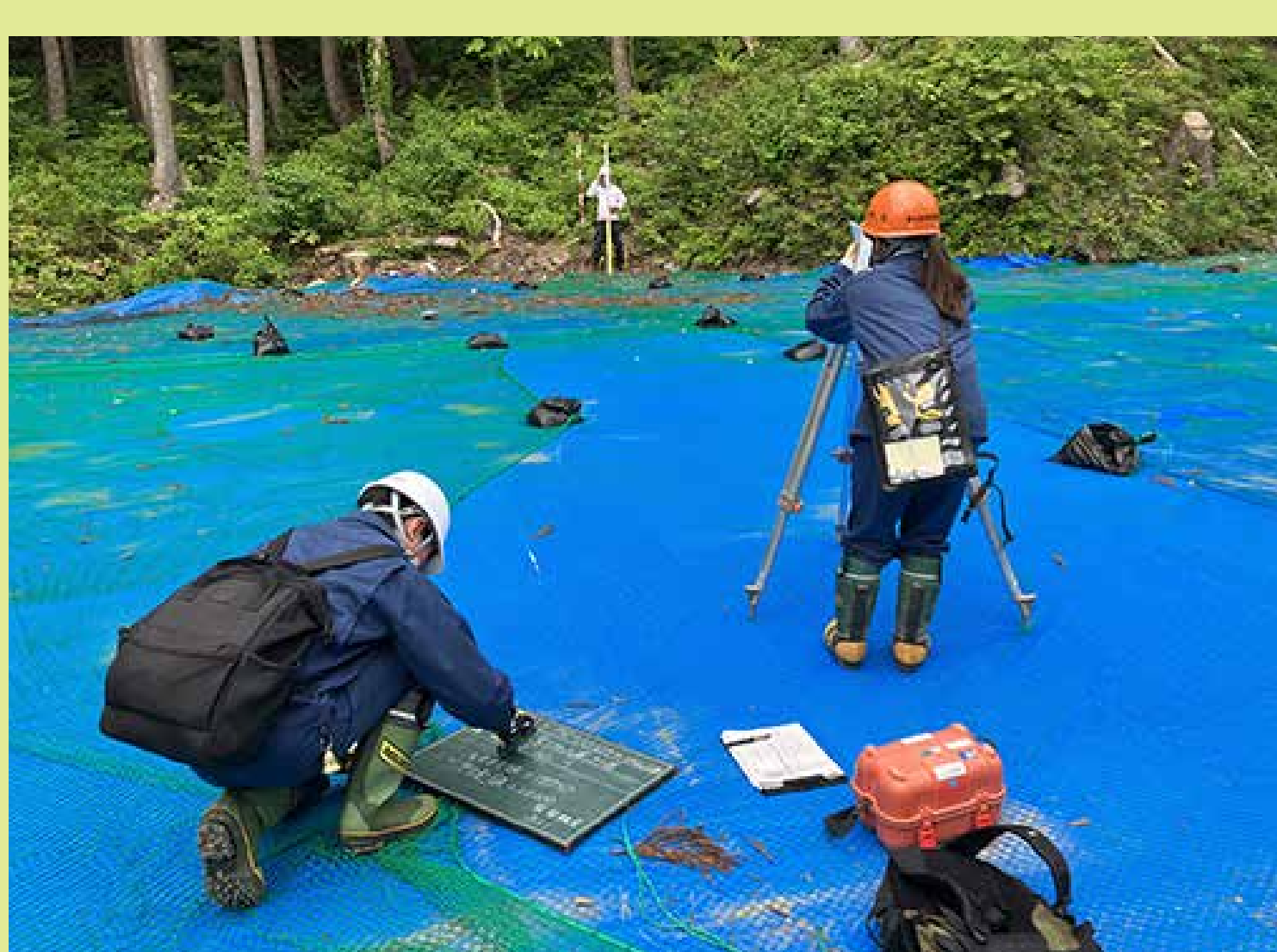
盛土の出来形確認 実施状況
