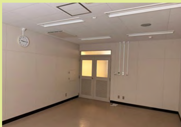
釜石森林事務所事務室（木質化前）
