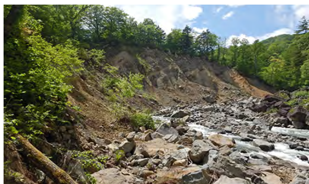
工事末端部の斜面崩壊状況
