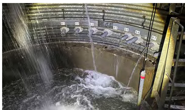
地下水集水状況
