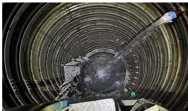
地下水排水状況
