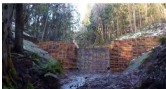
崩壊土砂流出危険地区において施工した コンクリート谷止工（秋田県南秋田郡五城目町）
