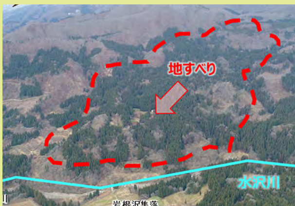
上小沼地区地すべり（全景）
