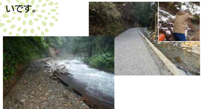
左：被災直後 右：工事完了後
