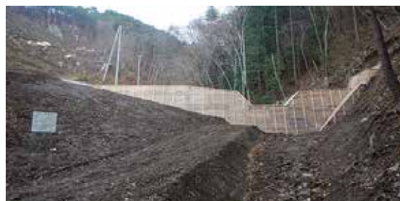
(シドケ沢) コンクリート谷止工完成
