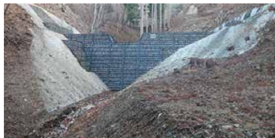
(田の浜) 鋼製枠谷止工完成
