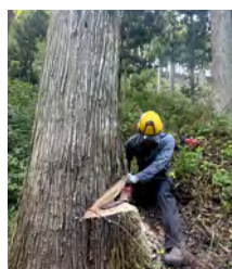
伐倒作業の様子
