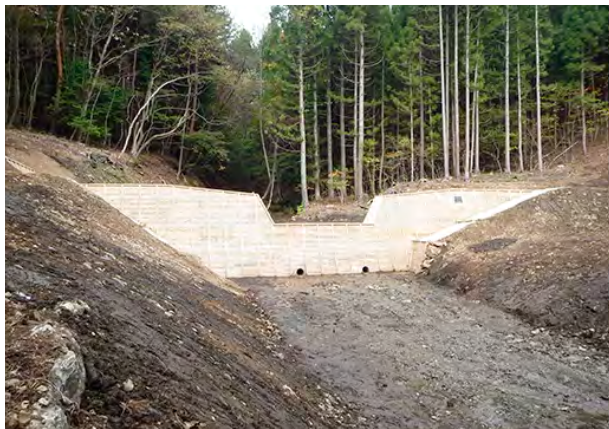
令和6年度に完成したコンクリート谷止工 (山田町豊間根 東山国有林内)
