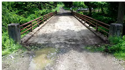
橋の清掃前(上)と清掃後(下)の様子
